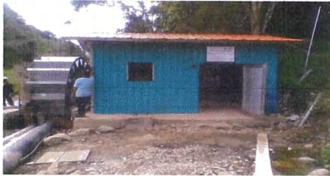
Fig. 2.5: Vista de la casa de máquinas de una central minihidráulica
