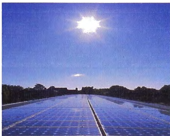
Fig. 2.2: Paneles fotovoltaicos de una Central Solar
