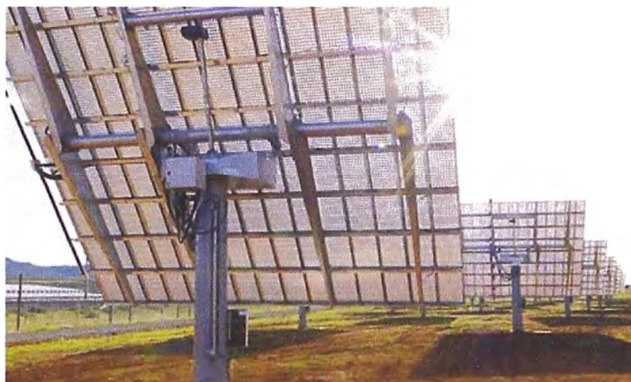
Fig. 5.6 Soporte móvil de 2 ejes (seguidor solar)
