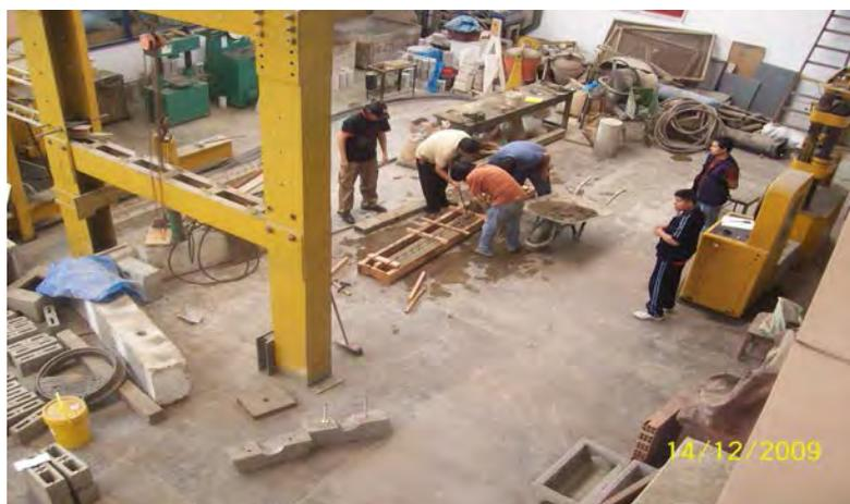
Foto N° 6.11: Elaboración de las viguetas de concreto en el L.E.M. por los alumnos.
