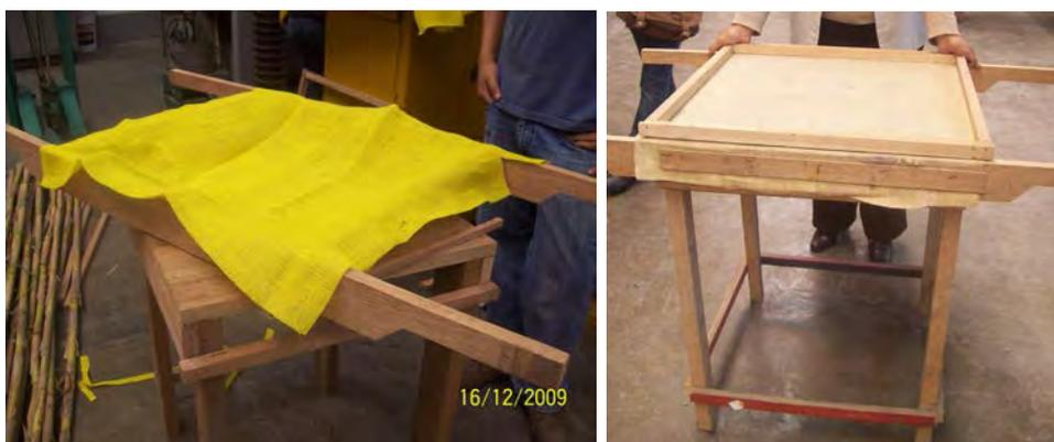
Foto N° 5.17: Habilitado de la madera para el encofrado del domo.
