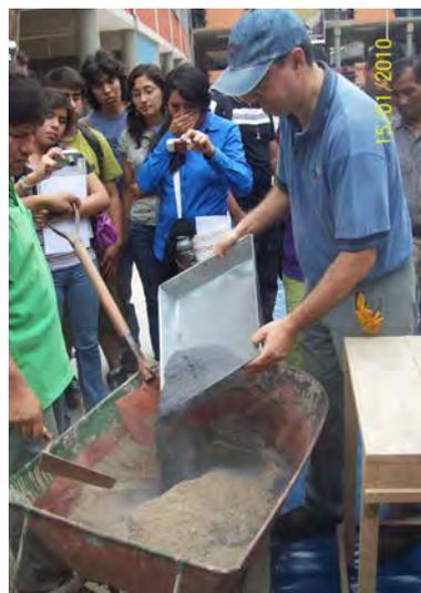
Foto N° 6.07: Preparación de la mezcla y elaboración de las bloquetas.
