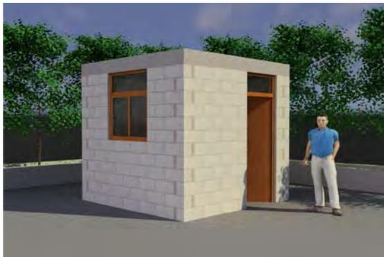
Figura N° 6.04: Vista del módulo elaborado a base de bloquetas de concreto.
