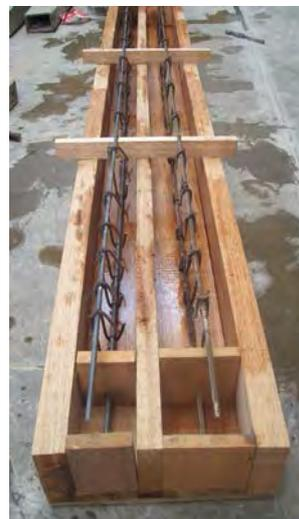
Foto N° 5.20: Encofrado para la elaboración de las viguetas de concreto.
