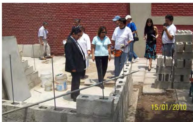
Figura N° 6.01: Vista del módulo elaborado a base de bloquetas de concreto.
