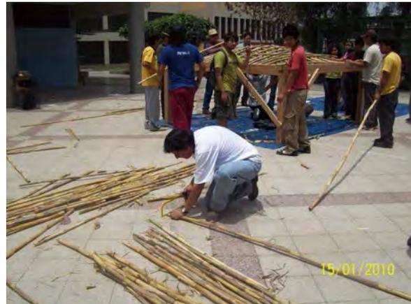
Foto N° 5.09: En la vista se aprecia el armado de la cúpula y el cortado de la caña.
