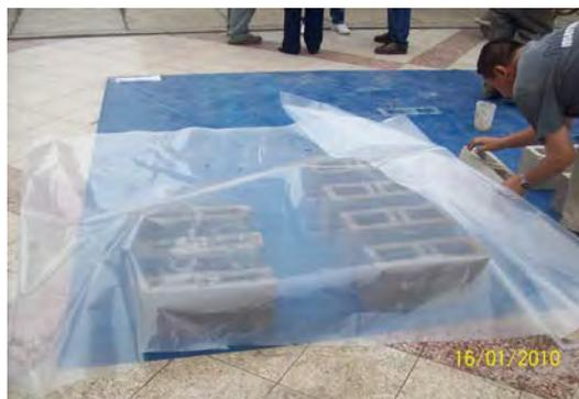
Foto N° 6.09: Bloquetas de concreto elaborados y proceso de curado.
