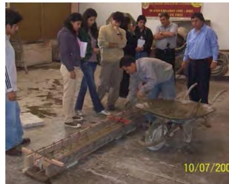
Foto N° 5.22: Proceso de elaboración de la viguetas de concreto.
