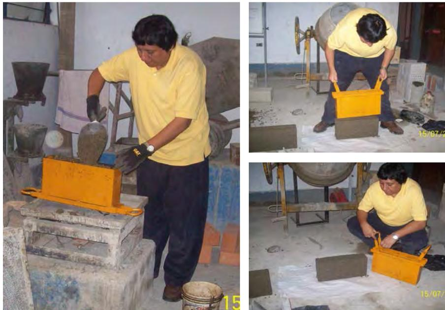
Foto N° 5.25: En la vista se aprecia la elaboración de las bloquetas.
