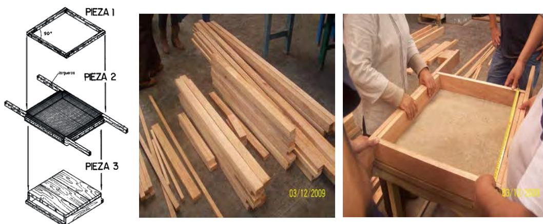
Foto N° 5.16: Habilitado de la madera para el encofrado del domo.
