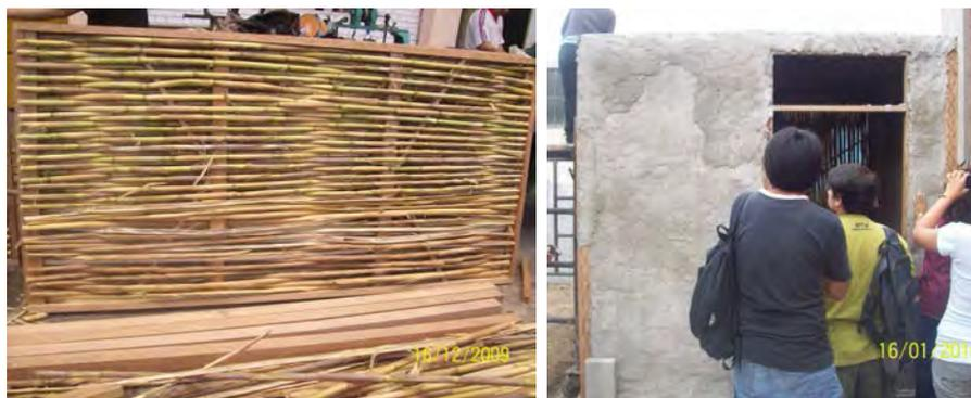
Foto N° 5.15: Se aprecia el bastidor terminado y revestido con mortero.
