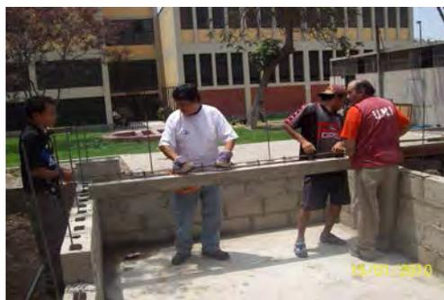
Foto N° 6.02: Vista del módulo elaborado a base de bloquetas de concreto.
