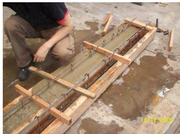
Foto N° 5.23: Vigueta prefabricada de concreto para el sistema techo Domozed.
