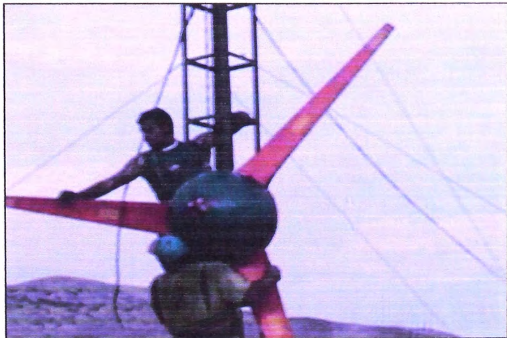
Gráfico 7.5 Subiendo el Rotor del Prototipo de Aerogenerador
