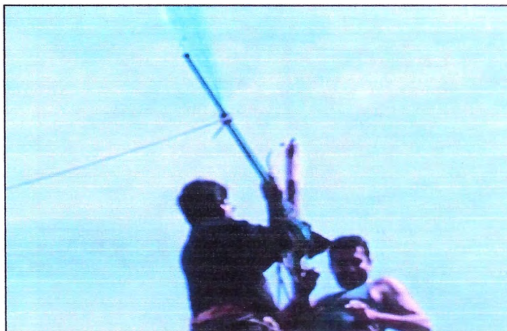
Gráfico 7.3 Colocando la Cola del Prototipo de Aerogenerador
