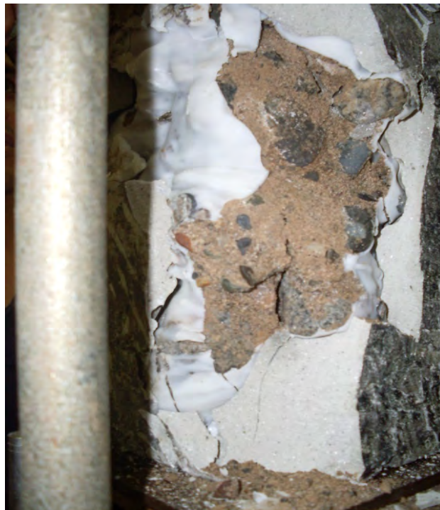
(a)Muestra ensayada con falla en forma de cuña
