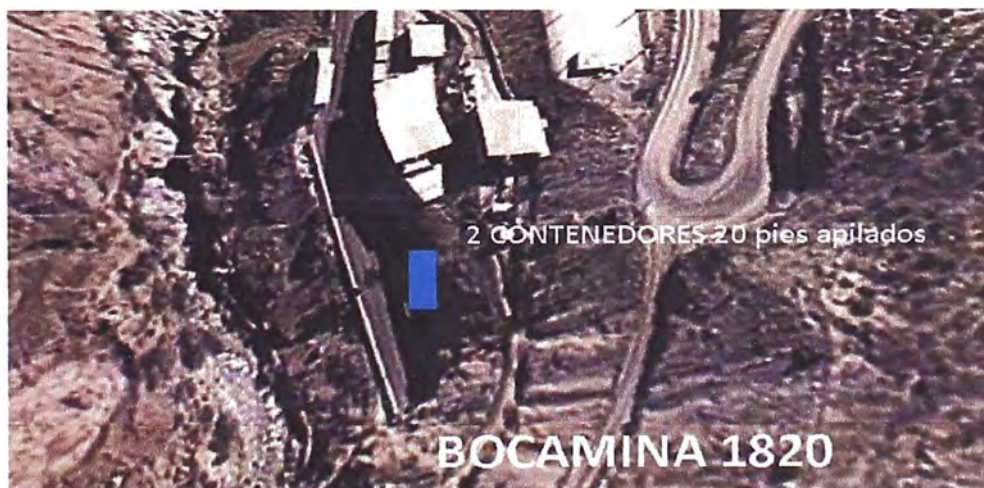
Fig. 4.3 Vista general de las oficinas y almacén en la bocamina 1820.
