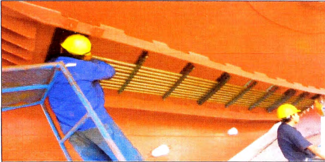
Figura 30. Sistema de enfriamiento por tubos de cupro-niquel.
