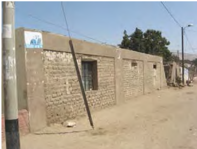
Fotografía N° 1 Casa Reforzada en Guadalupe, Ica, después del Sismo del 15-08-2007
