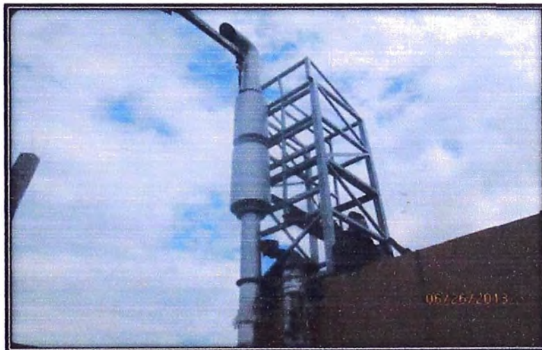
Figura 5.29 Montaje y fijación de la primera línea tubería de escape de 10" \varnothing con resonadores de 12" \varnothing
