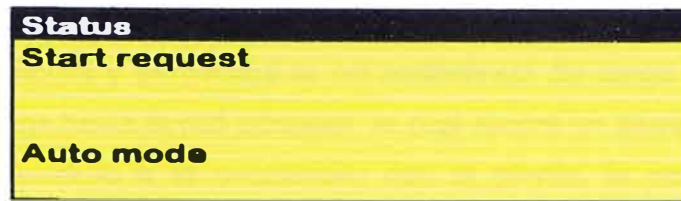
Figura 5.65 arranque de grupos electrógenos listos para asumir la carga- modo automático.
