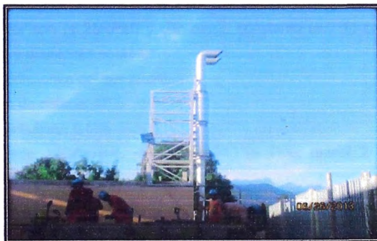
Figura 5.33 Vista de perfil de culminación de montaje de primera y segunda línea tubería de escape de 10 "Ø con resonadores de 12" Ø
