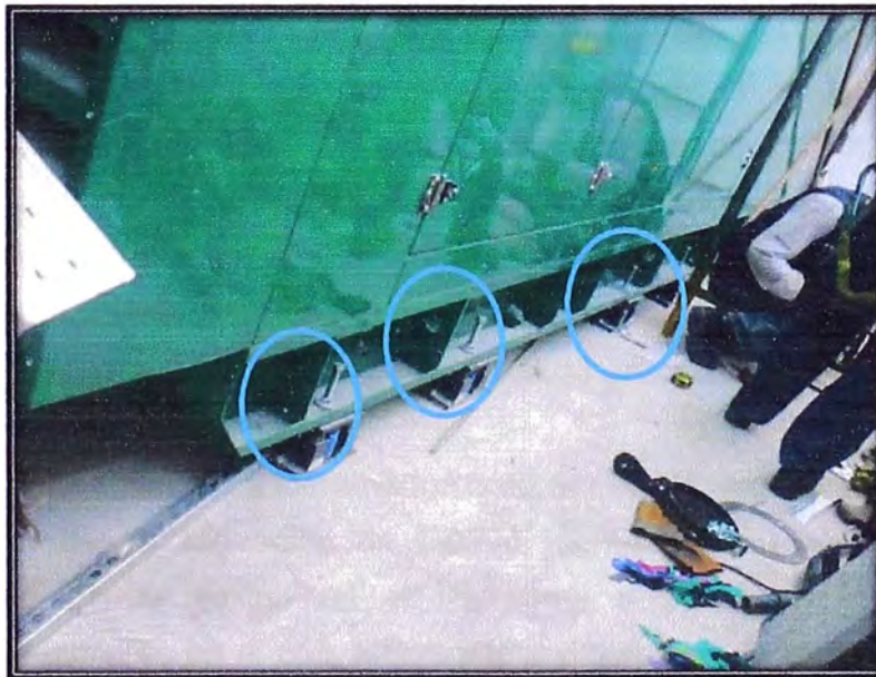
Figura 3.12 Instalación de resilientes tipos resorte (segundo piso) de tienda comercial.
