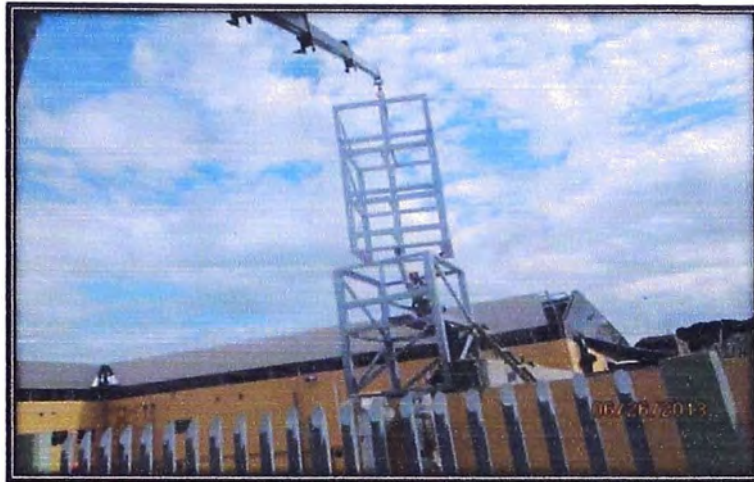
Figura 5.28 Dirigiendo estructura para soporte de tubería de escape por encima del techo del cuarto de fuerza.
