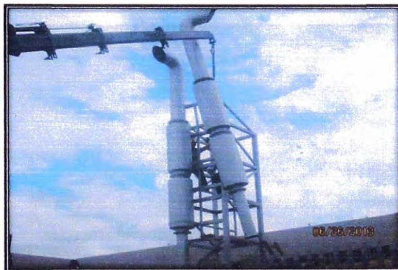
Figura 5.31 Dirigiendo segunda línea tubería de escape de 10 "Ø con resonadores de 12" Ø
