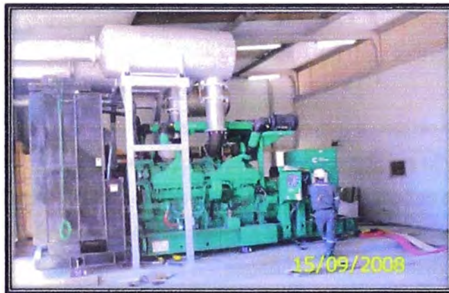
Figura 3.5 Consideraciones de diseño de instalación con silenciador
