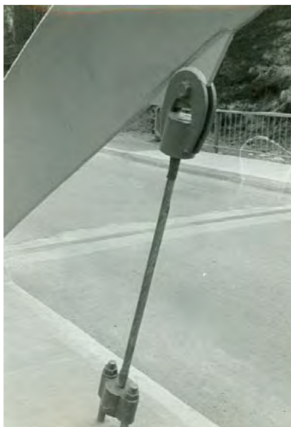
Figura 1-11: Péndola extrema de un puente en arco atirantado Fuente: Tveit [13]
