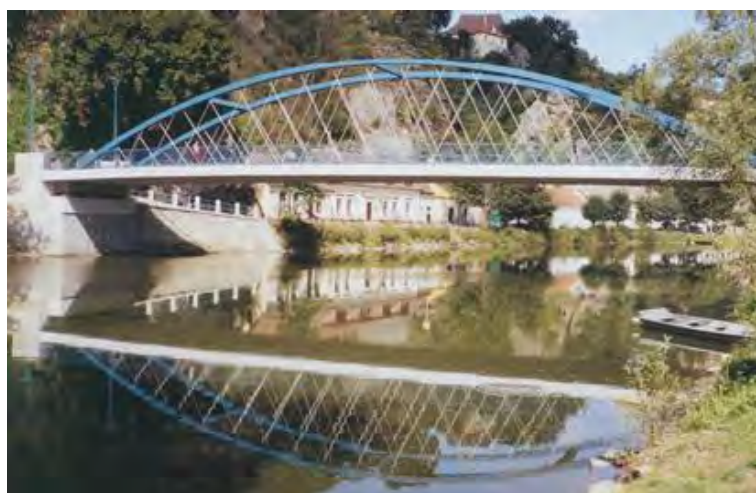
Figura 1-6: Puente Bechyne (42 m), República Checa, 2004 Fuente: Tveit [13]
