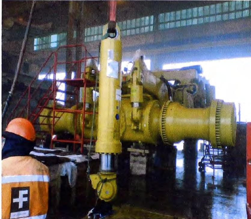
Fig.3,14 Instalación del cilindro de levante de tolva.
