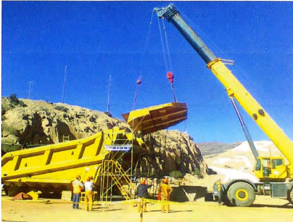
Fig.3,20 Instalación de la visera (canopy) de la tolva del camión.
