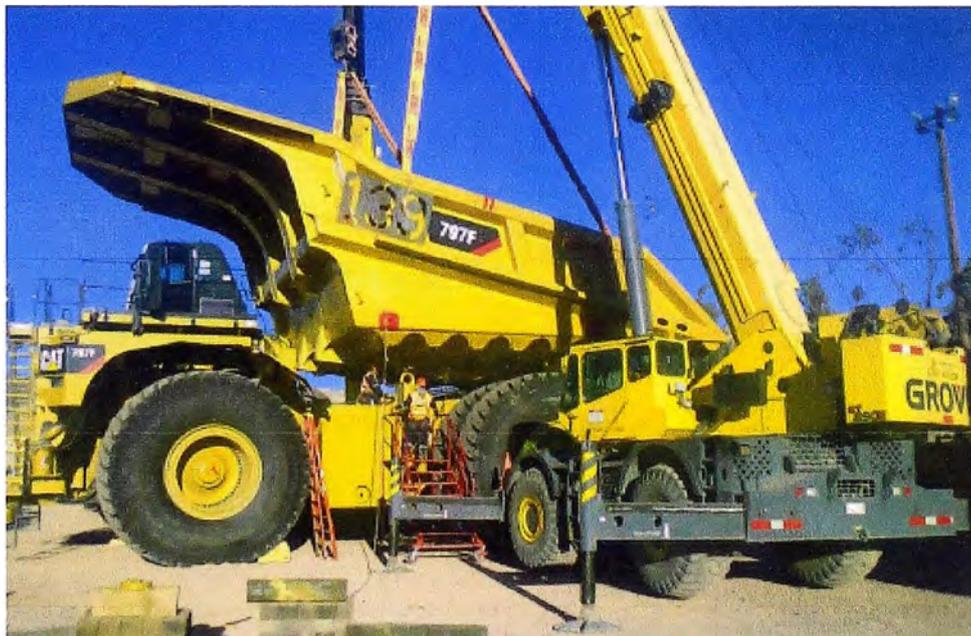
Fig 3,21 Instalación de la tolva en el camión.
