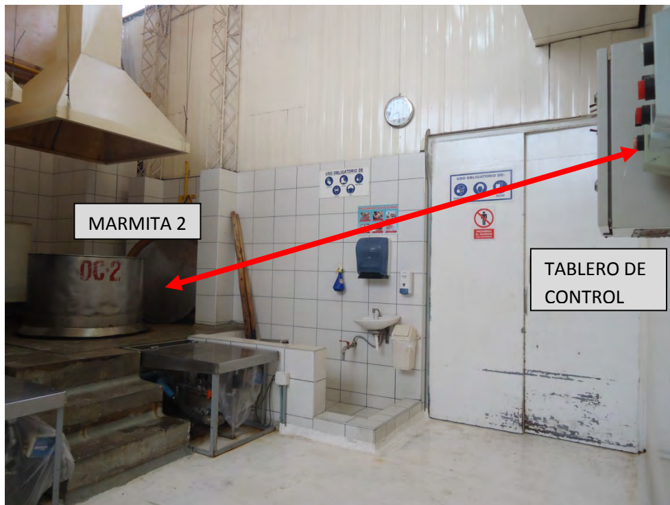
Figura G.2: Distancia del tablero de control a la marmita Fuente: Fotografía tomada por la autora, diciembre del 2012.
