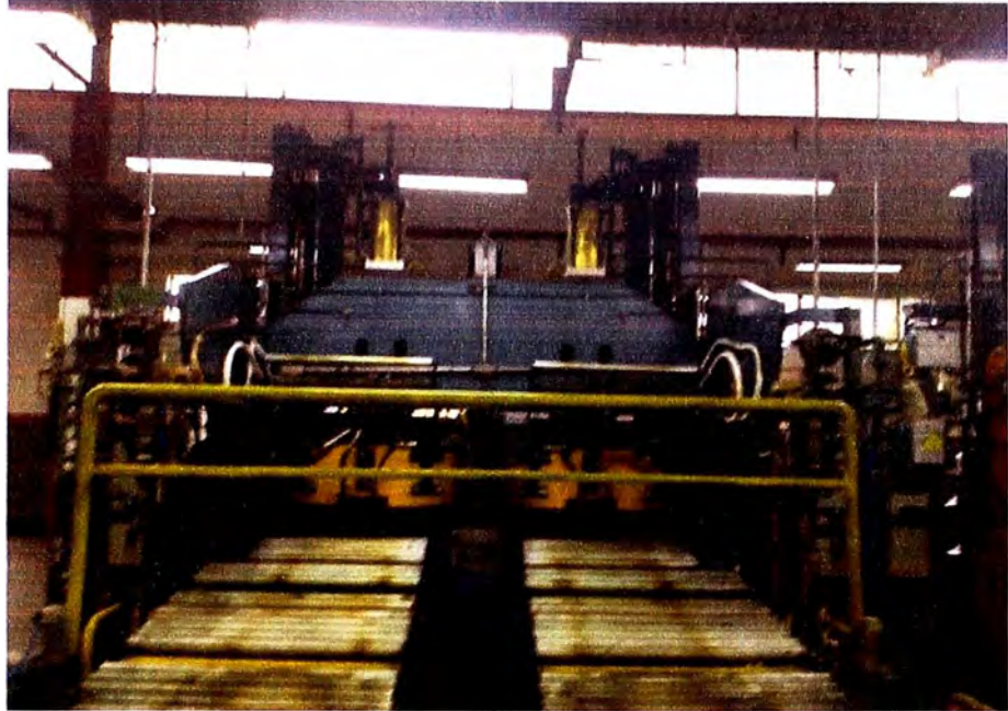
Figura 2.7 Rampa de descarga
