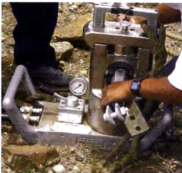
Figura 4.4 Empalme de terminales de compresión
