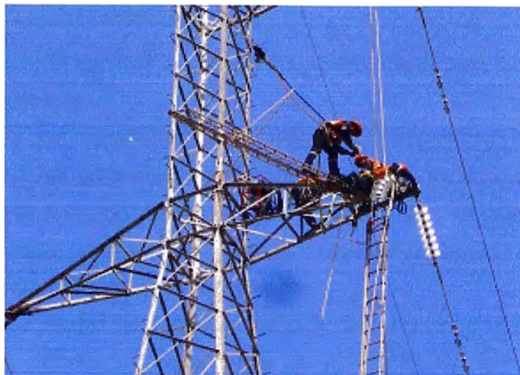
Figura 4.5 Instalación de Cadena de Aisladores
