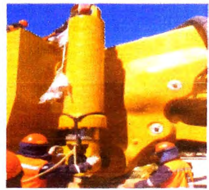
Fig.4.8.3 INSTALACION DE ELEMENTO DE SUJECION DEL CILINDRO DE LEVANTE
