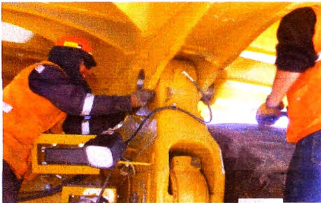
Fig.4.13.3 INSTALACIÓN DE PIN DE VOLTEO
