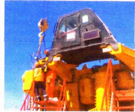
Fig.4.7.3 IZAJE Y MONTAJE DE LA CABINA
