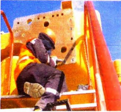
Fig.4.7.1 LIMPIEZA DE SUPERFICIE DE CONTACTO Y RETIRO DE BAQUELITA
