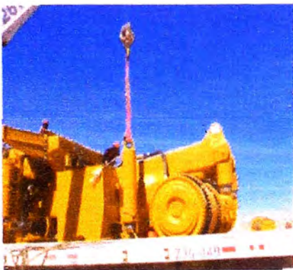
Fig.4.8.1 IZAJE Y MONTAJE DE CILINDROS DE LEVANTE
