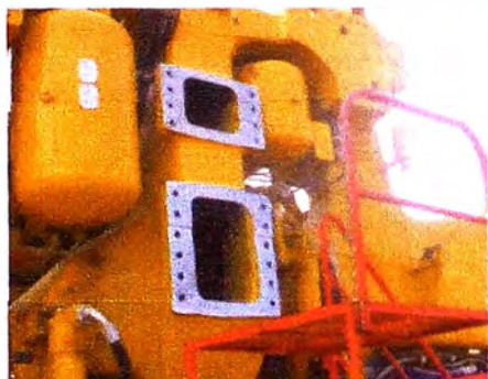
Fig.4.6.1 LIMPIEZA DE ALOJAMIENTOS Y INSTALACION DE CHAVETA
