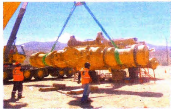
Izaje e instalación del eje posterior
