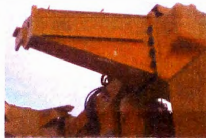
Fig.4.7.2 IZAJE Y MONTAJE DE SOPORTES DE CABINA Y TORQUE DE PERNOS DE PERNOS
