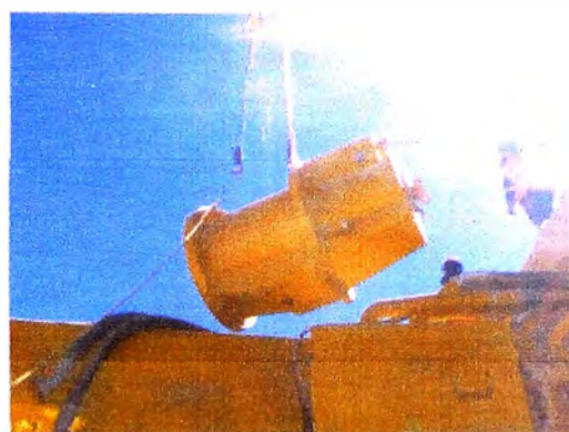
Fig.4.9.2 IZAJE Y MONTAJE DE TRANSMISIÓN
