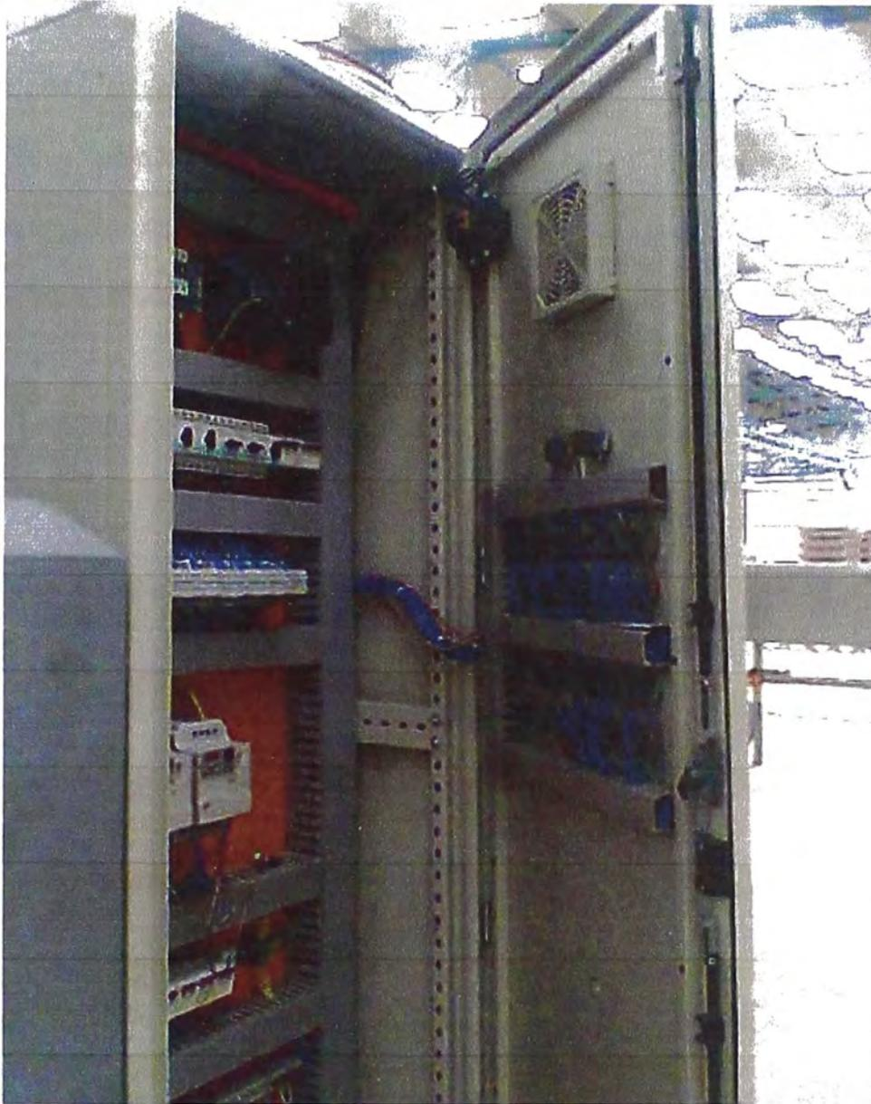
**Fig. 5.13: Tablero eléctrico y de control de la línea aerotransportadora**
