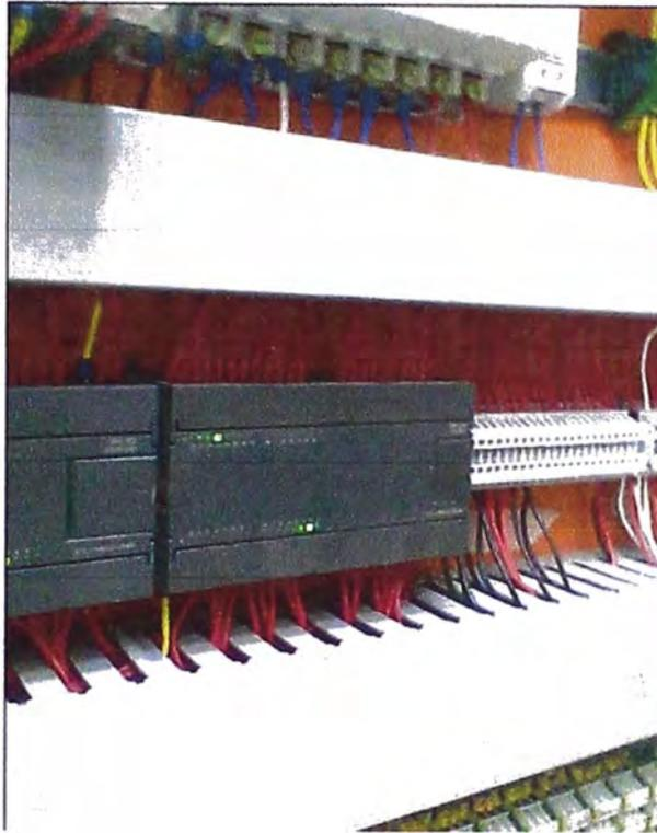
**Fig. 5.15: Instalación del PLC SIEMENS S7-224 en tablero existente**
