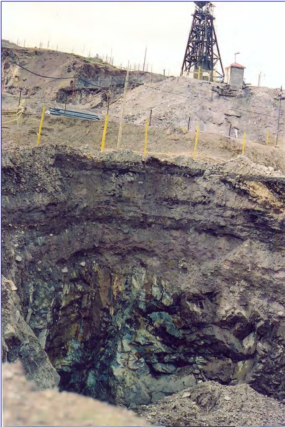
FOTO 02: Vista de la pared del forado mirando Este Oeste, nótese los horizontes que sobreyacen al macizo rocoso. En la parte superior se observa el Glory Hole más próximo al pique Montenegro. Notese los vórtices generados por la turbulencia del agua.
