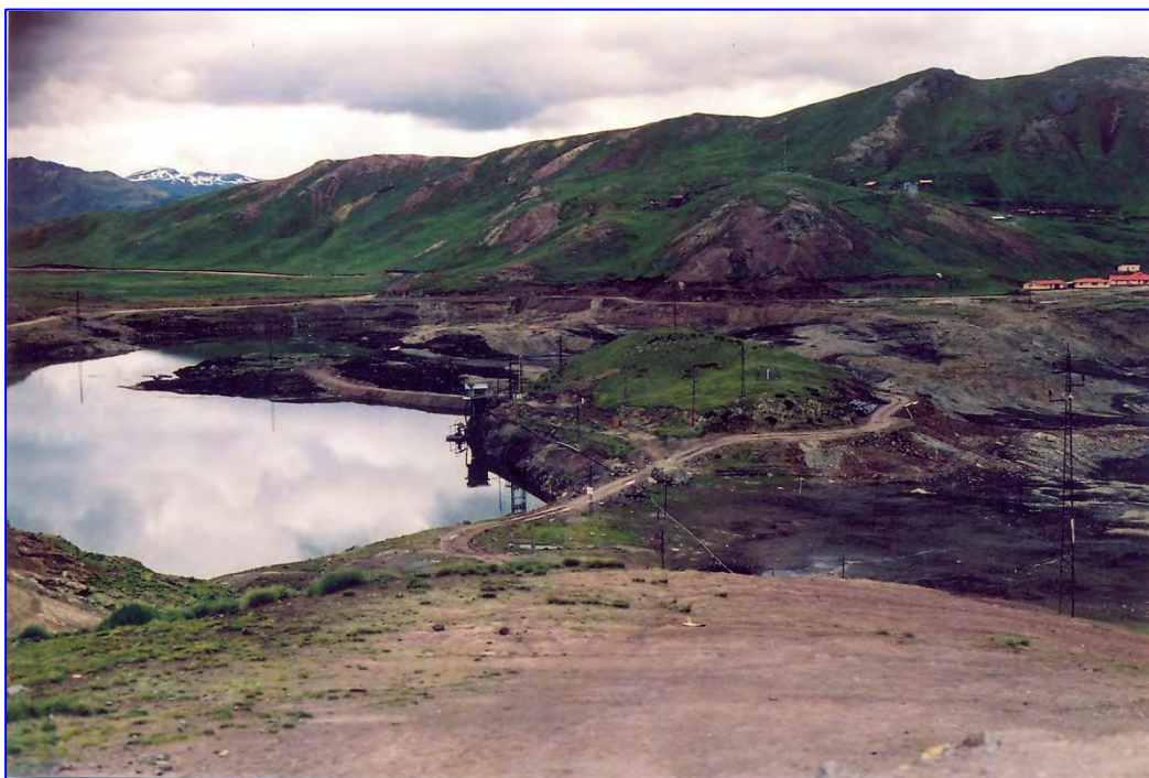
FOTO 11: Vista panorámica del dique que regula el drenaje de la laguna Huaroncocha a Naticocha.
