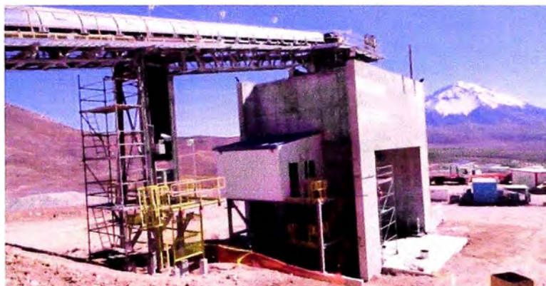
Figura 2,15: Vista de la Tolva de carguío de camiones.
