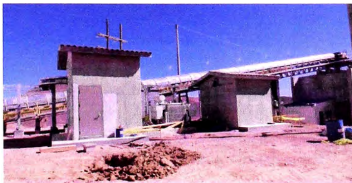
Figura 2,14: Vista de la Sala Eléctrica N°06.
