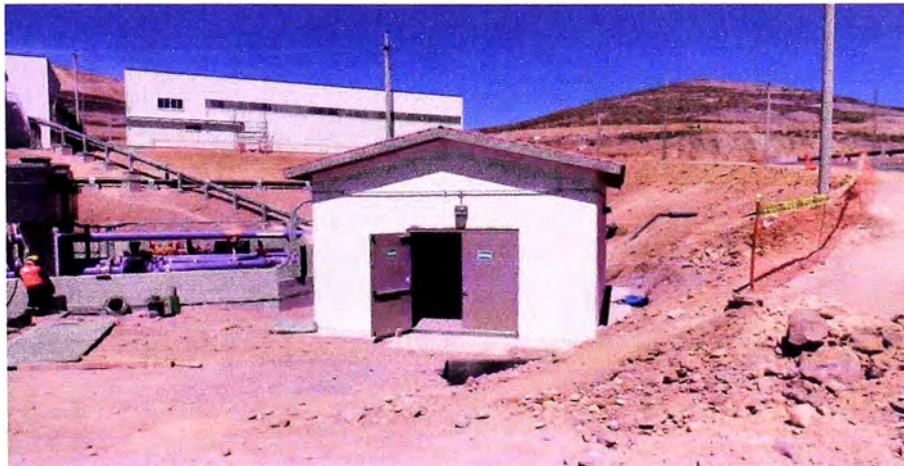
Figura 2,20: Vista de la sub Estación eléctrica.
