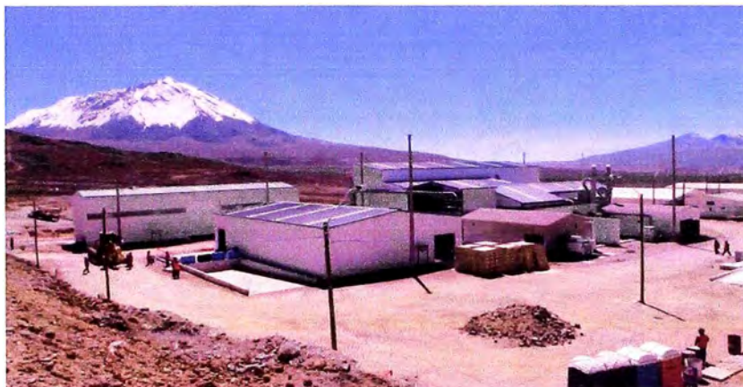
Figura 2,21: Vista de la sub Estación eléctrica.
