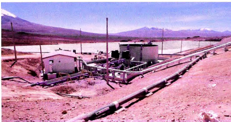
Figura 2,16: Vista completa del área de Lixiviación
