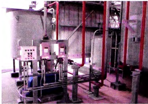
Figura 3,5 Montaje de seccionadores de aislamiento.
