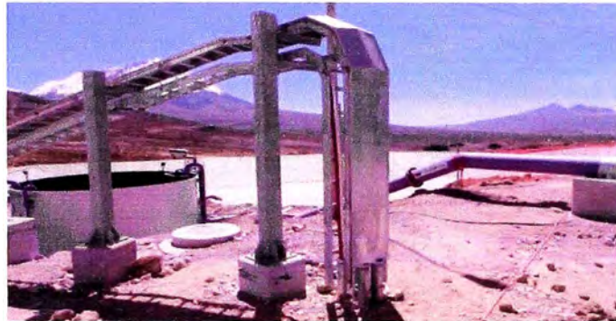
Figura 3,6 Montaje bandeja portacables desde Sala eléctrica ADR hacia zona de Lixiviación
