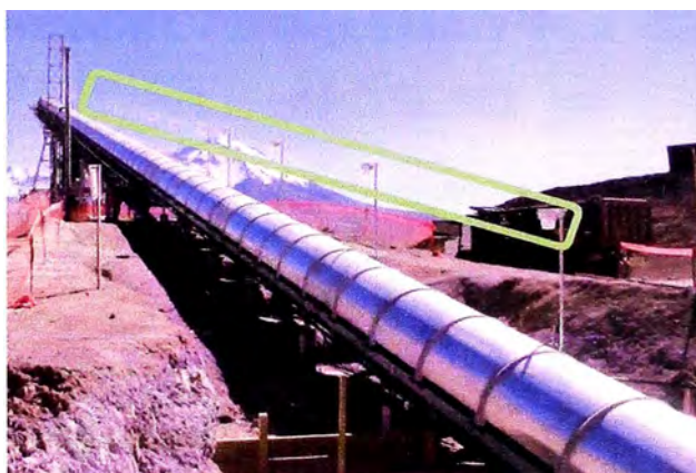
Figura 3,6: Montaje de luminarias tipo MERCMASTER
