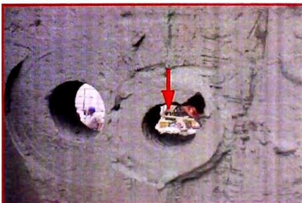
**Fig. 5.14 Reparación x soldadura de 10 agujeros roscados (cambio de insertos, bocinas roscadas)**
