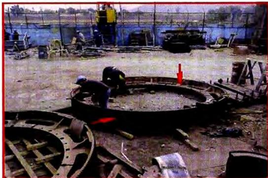
**Fig. 5.33 Pre montaje, aplicación de tintes y verificación de medidas**
