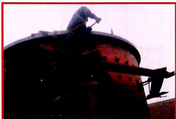
**Fig. 5.15 Rectificación de agujeros roscados de la brida del casco de molino.**
