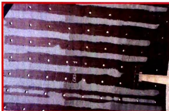
**Fig. 5.16 Trabajos de reparación con masilla metálica en zonas socavadas.**
