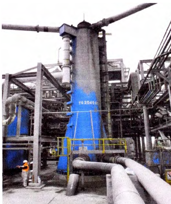
Figura P3 : Tanque metálico
