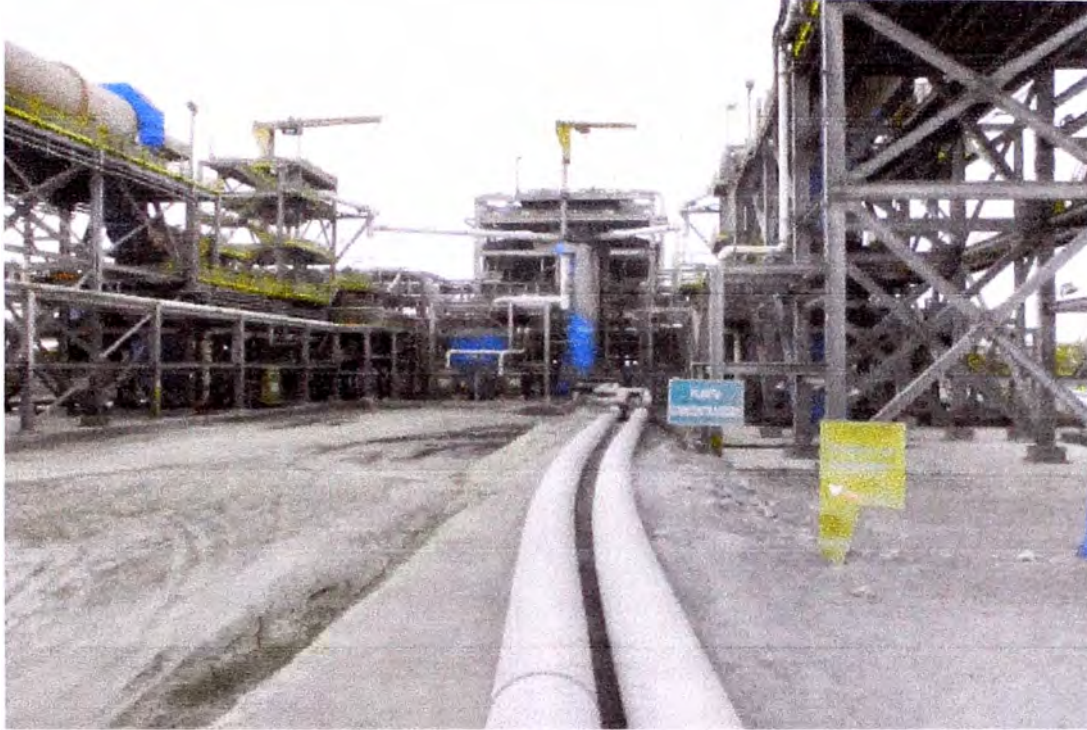
Figura P4 : Tanque metálico y Tubería de relaves finos
