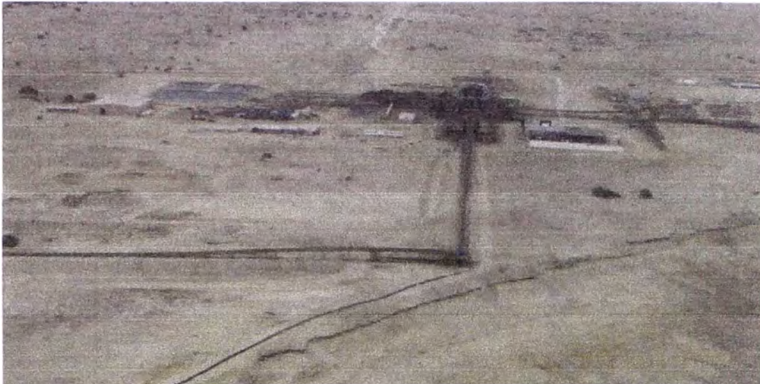
Figura P2: Tubería de relaves finos (0+000 @ 0+700 aprox.)
