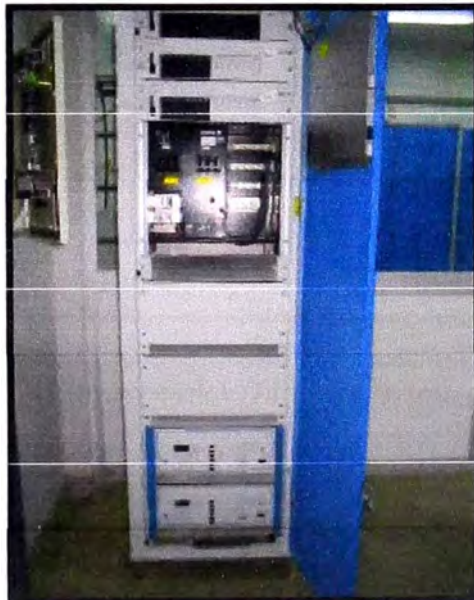
Fig. 2.10: Rectificadores de 33 Amp. - Ura San Jerónimo – Huancayo).
