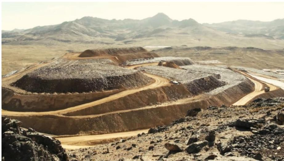
Figura N° 3.26 Botadero de desmonte (*waste dump*) Mina Corihuarmi – Yauyos, Lima Perú
