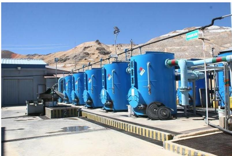
**Figura N° 3.35** Columnas con carbón activado, Mina Corihuarmi – Perú
