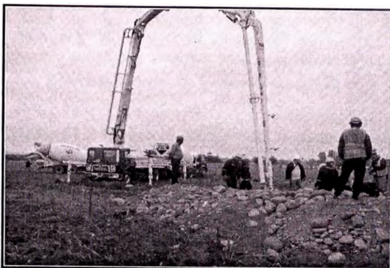
Figura 3-11 Vaciado de concreto con mixer torre 125 – Pata D.
