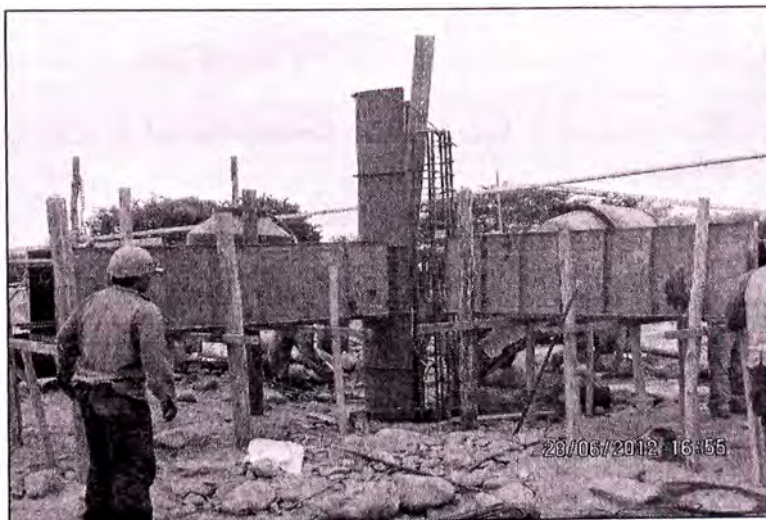
Figura 3.13 Vaciado de concreto a cimentación especial tipo Caisson
