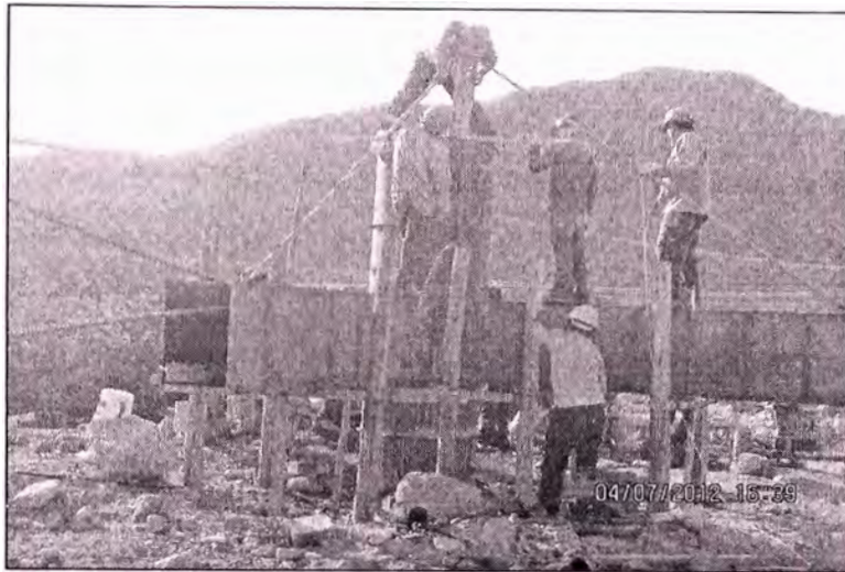
Figura 3.14 Vaciado de concreto a cimentación especial tipo Caisson
