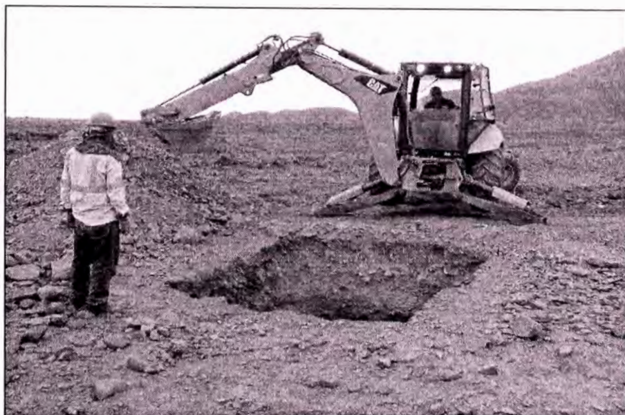
Figura 3-7 Excavación (maquinaria pesada) torre T389 – Pata C.
