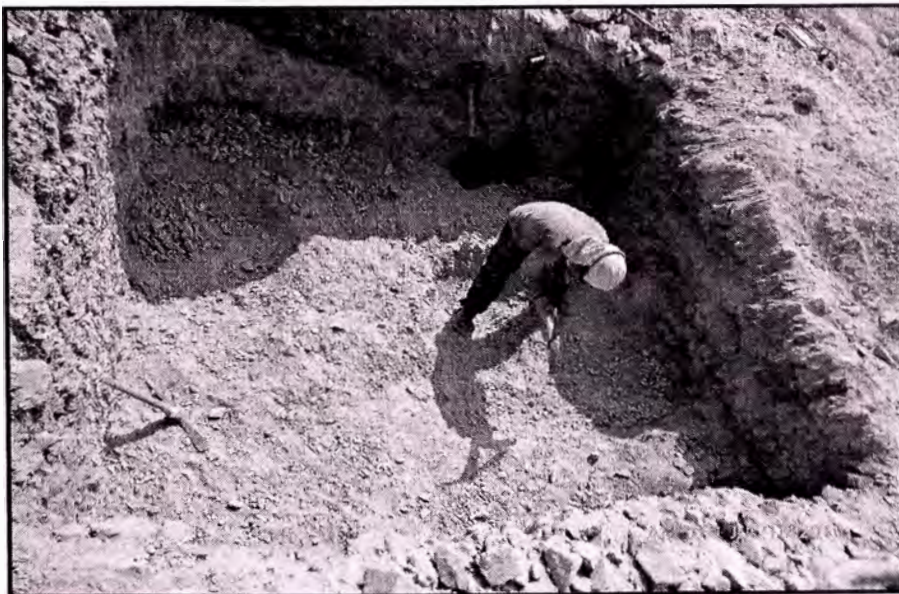
Figura 3-5 Excavación (manual) torre 34 – Pata A.
