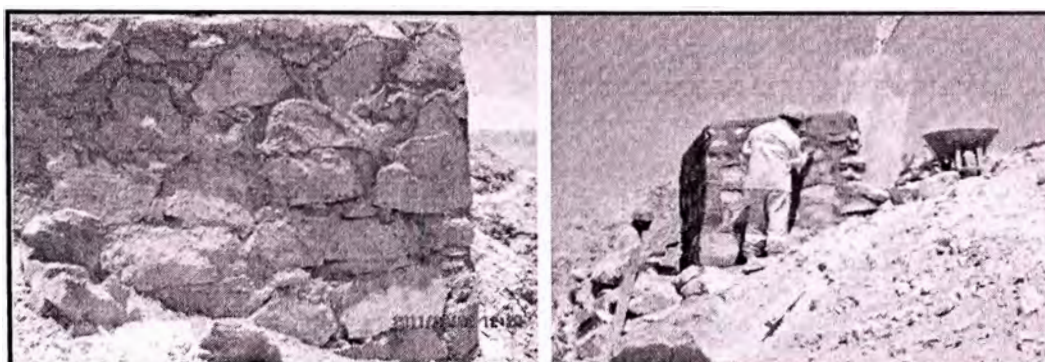
Figura 6-2 Configuración de muros secos.
