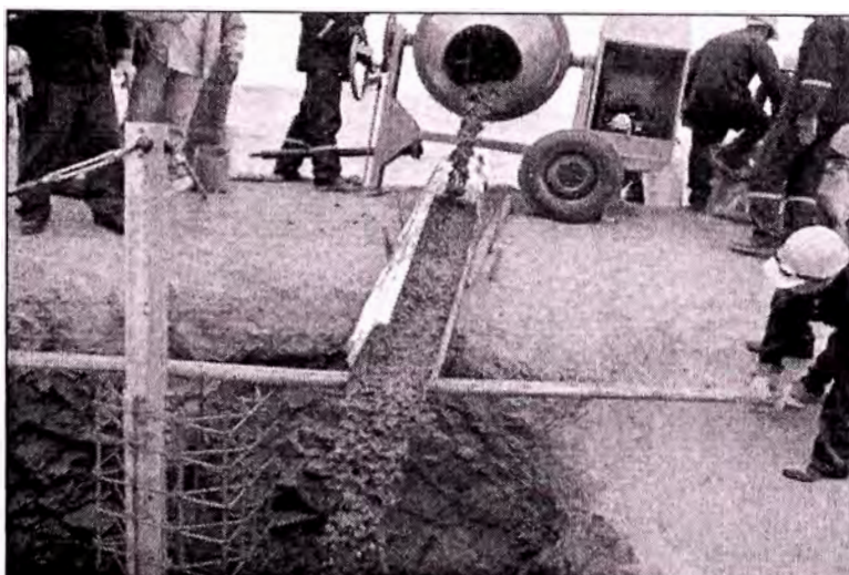
Figura 3-12 Vaciado de concreto torre 140 – Pata C.
