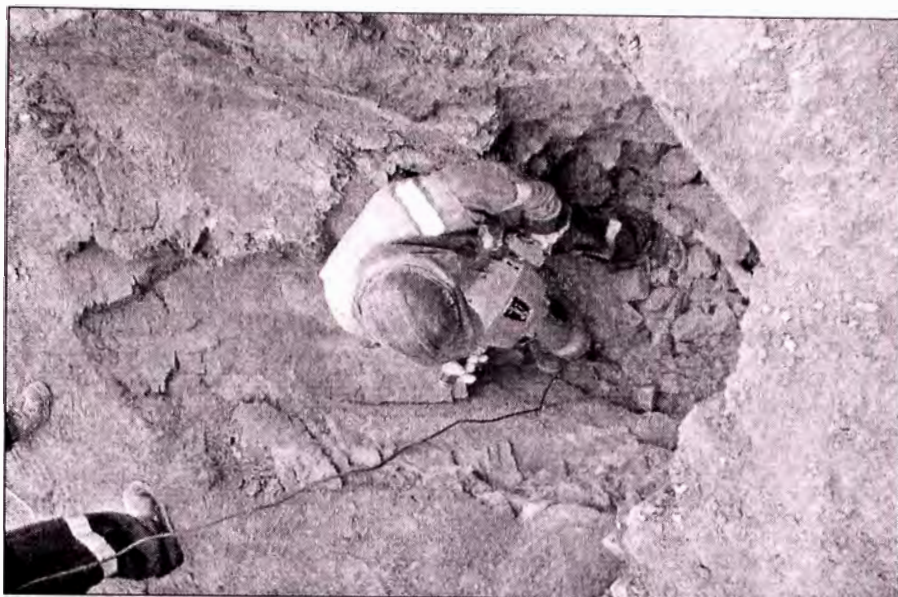
Figura 3-6 Excavación (taladro) torre T425 – Pata B.
