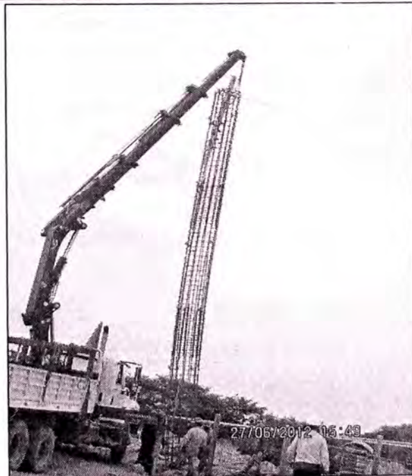
Figura 3.10 Armadura de hierro para cimentación tipo Caisson
