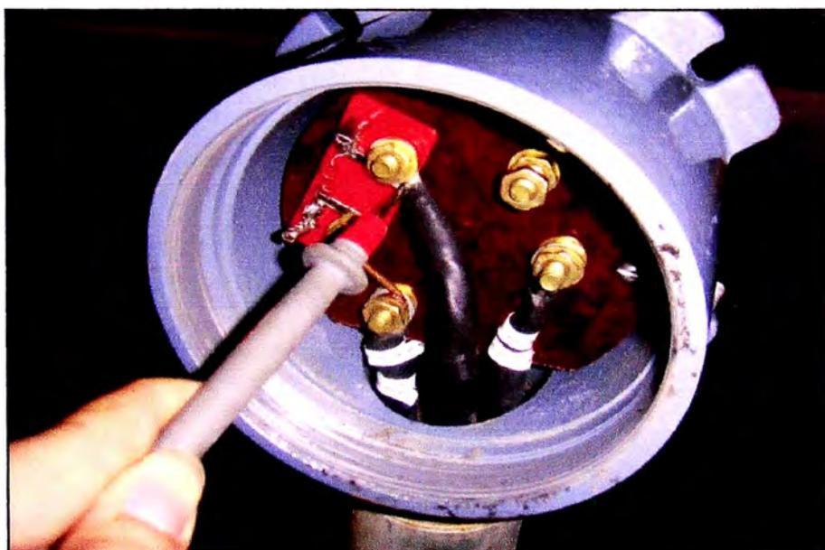
Figura 4.5 – Medición de potencial de tubería (Actividad considerada HP) (Fuente: Foto tomada Mayo 2010)
