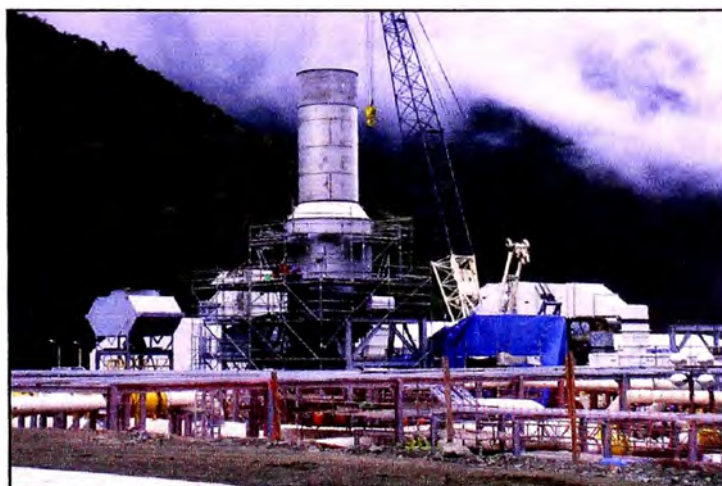
Figura 3.2 – Instalación de ducto de Gases de escape de Turbocompresor A (Fuente: Foto Tomada en Agosto 2009)
