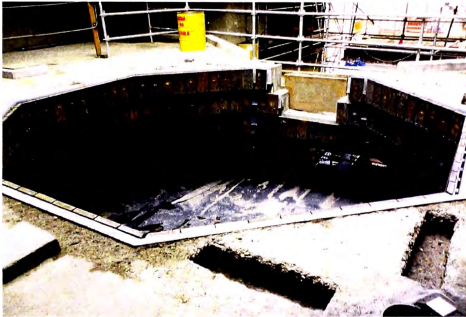
Figura 4.6 Cimentación de la Chancadora Giratoria.
