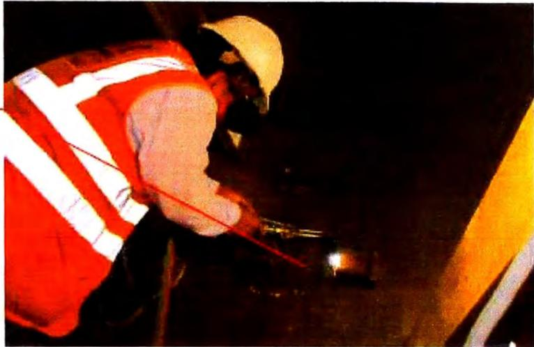
**Figura 5.36.:** Retiro de utillaje con proceso de corte Arc Air.
