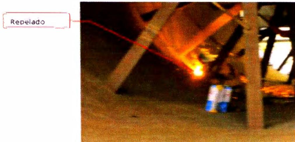
**Figura 5.38.:** Pre calentamiento durante el repelado.
