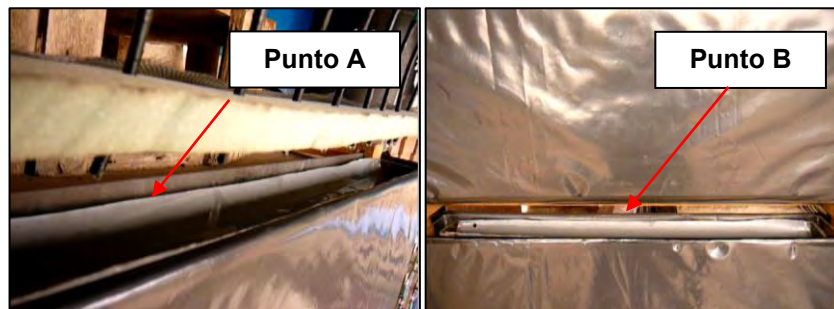
Fotografía N° 5.49: Tomador de muestra en el Punto A y B
