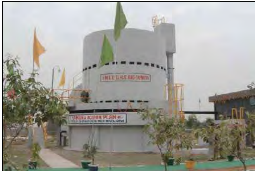
Figura 3.7: Reactor DHS concluido en la Karnal, India – 2001
