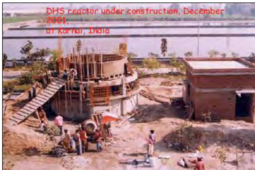
Figura 3.6: Reactor DHS en construcción en la Karnal, India – 2001
