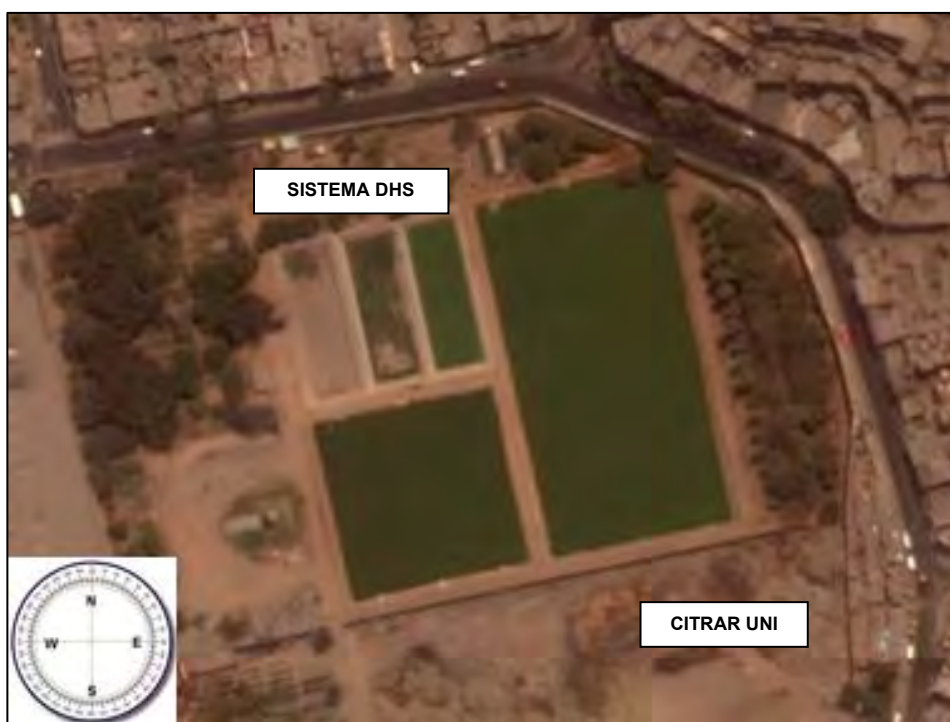
Fotografía N° 5.1: Ubicación del sistema DHS tipo bloques prismáticos
