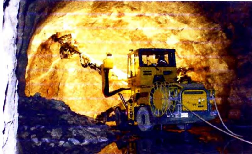
Figura 3.3.- Jumbo en proceso de perforación
