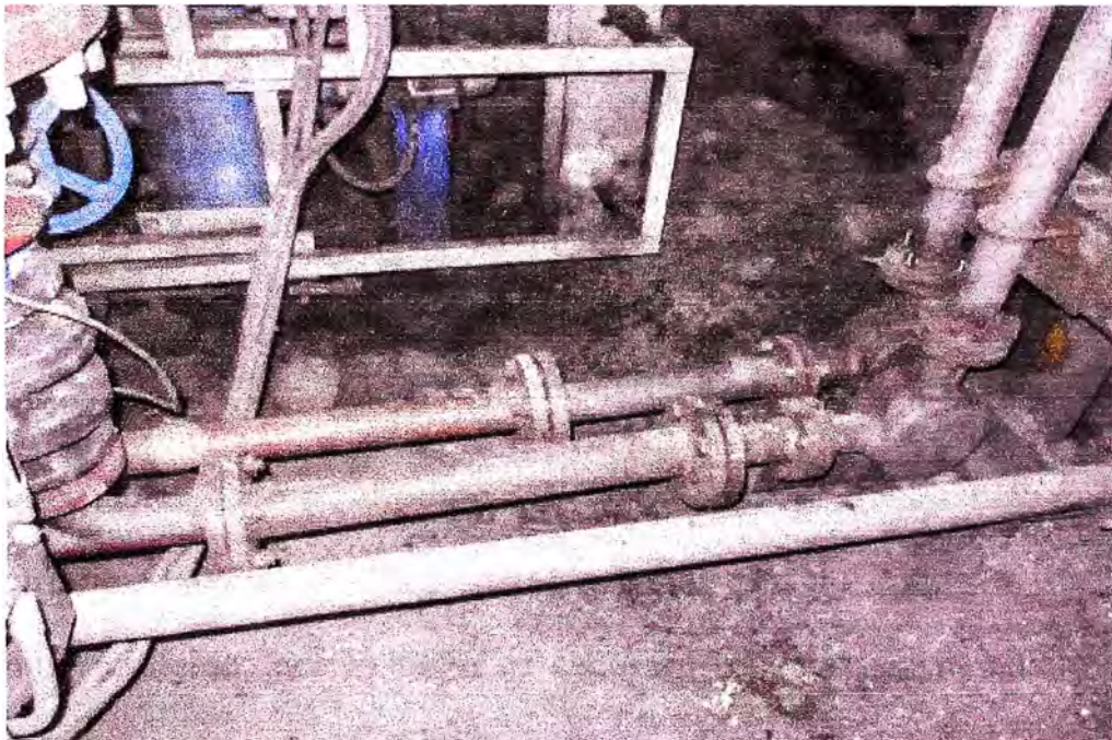
Figura 4.3 Disposición de tuberías de Carbón.
