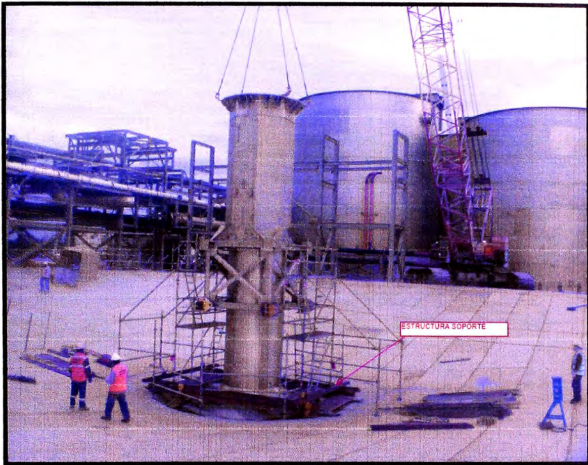
Foto 4.2: Instalación del drive shaft
