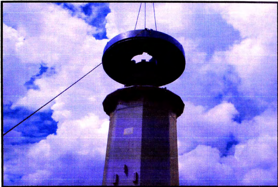
Foto 4.3: Instalación del gearunit
