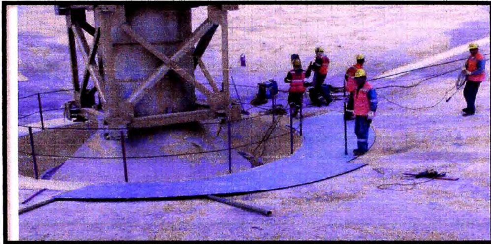
Foto 4.4: Instalación del inner ring
