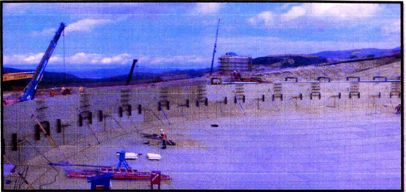
Foto 4.7: Armado del casco
