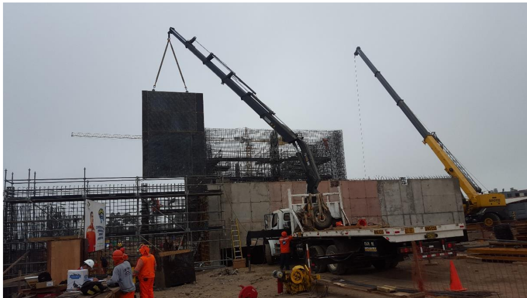
Colocado de encofrado con camión grúa y grúa hidráulica.
