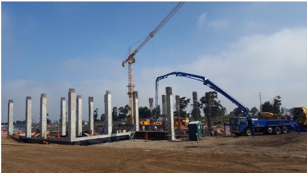
Colocado de concreto con grúa torre.
