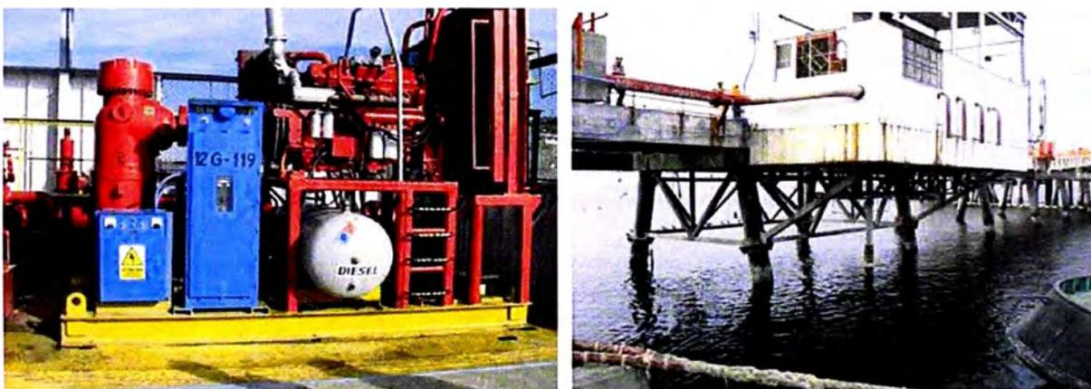
Ilustración 0-1: Disposición de equipos y estructura de la casa de máquinas del Sistema Contra Incendio del Muelle del Terminal Bayóvar.
