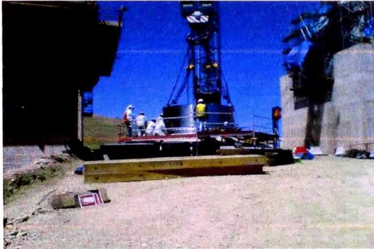
**Fig. 5.70 Colocación de maniobras para tandem de tapa-trunnion, (Proyecto Antapaccay).**
