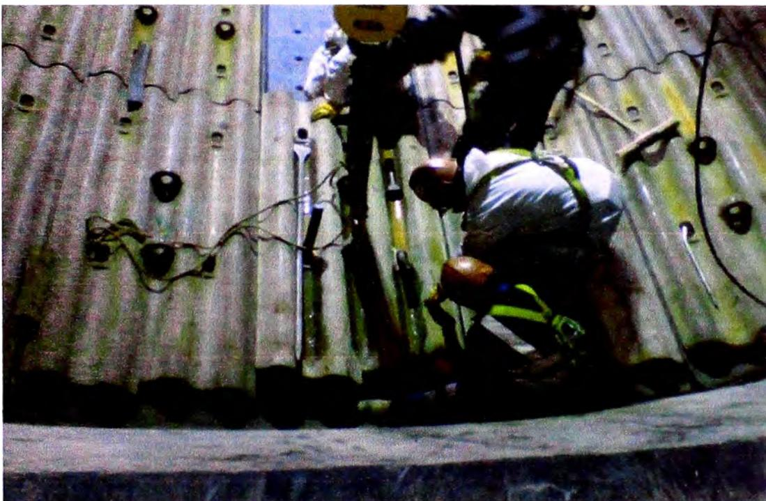
**Fig. 5.120 Montaje de última fila de corazas en shells, (Proyecto Antapaccay).**
