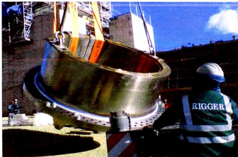
**Fig. 5.61** Izaje de trunnion, e inicio del levantamiento del gancho en el cual están colocados los estrobos, (Proyecto Antapaccay).
