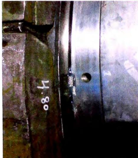
**Fig. 5.135 Colocación de shims o laines, (Proyecto Antapaccay).**
