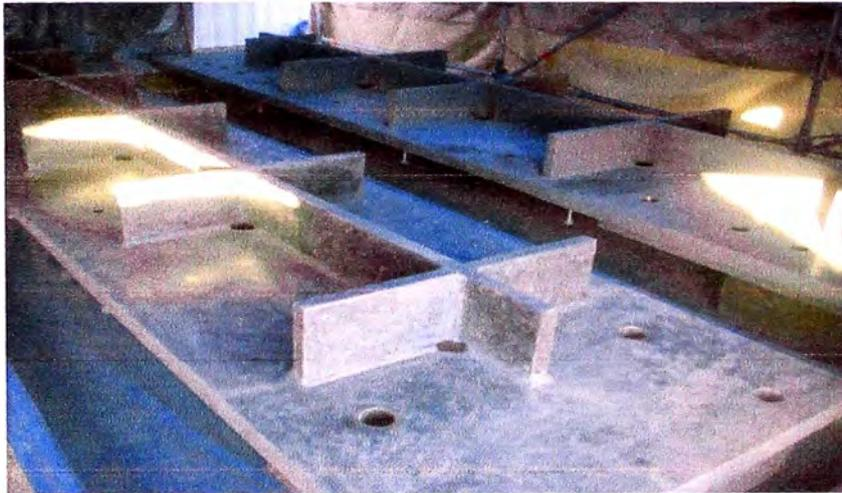
**Fig. 5.11 Limpieza de la zona de la llave del soleplate, (Proyecto Antapaccay).**
