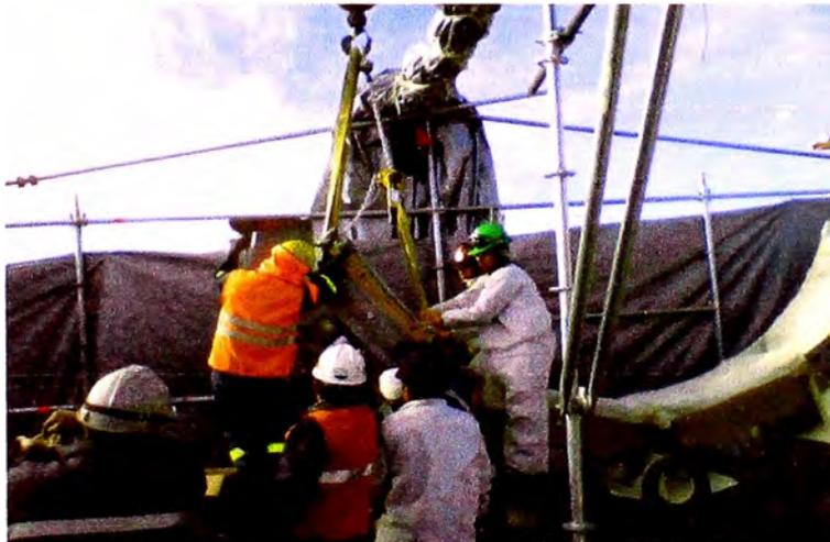
**Fig. 5.38 Armado de cojinetes principales, (Proyecto Antapaccay).**
