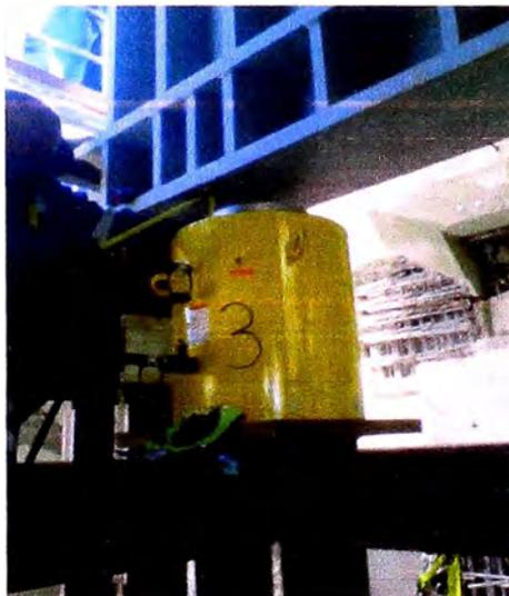
**Fig. 5.79 Conexión de mangueras en gatas, (Proyecto Antapaccay).**
