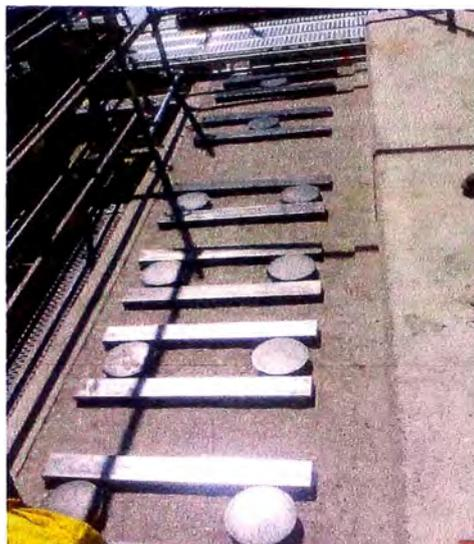
**Fig. 5.148 Distribución de placas de nivelación, (Proyecto Antapaccay).**
