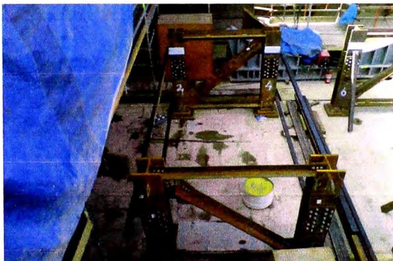
**Fig. 5.45 Soportes de fijación de cunas, (Proyecto Antapaccay).**
