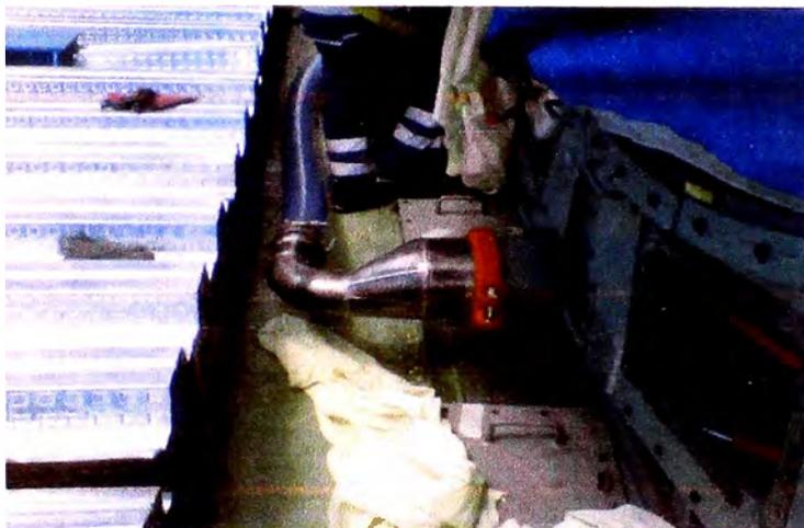
**Fig. 5.82 Tubería de retorno desde cojinete principal hacia tanque en unidad de lubricación temporal, (Proyecto Antapaccay).**
