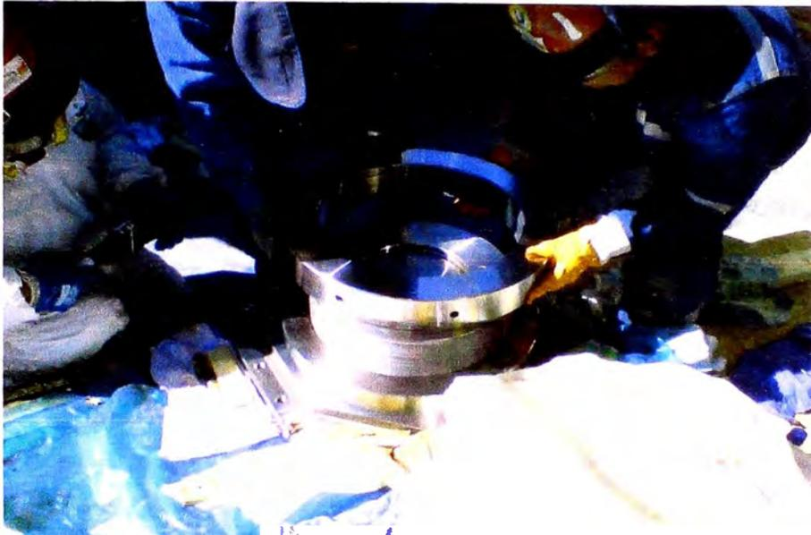
**Fig. 5.33 Instalación de tuerca en gatos hidráulicos, (Proyecto Antapaccay).**
