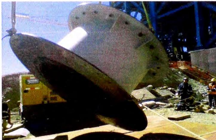
**Fig. 5.132 Tandem trunnion liner de descarga, (Proyecto Antapaccay).**
