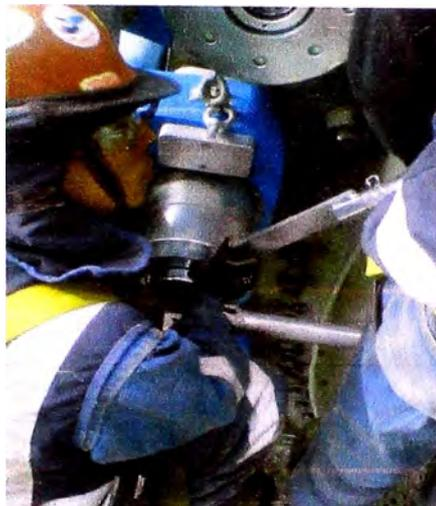
**Fig. 5.103 Colocar llave de ajuste, (Proyecto Antapaccay).**
