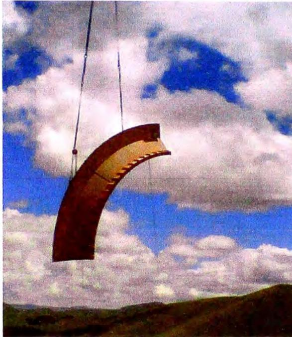
Fig. 5.226 Izaje de tapa superior de bobina lado de descarga, (Proyecto Antapaccay).
