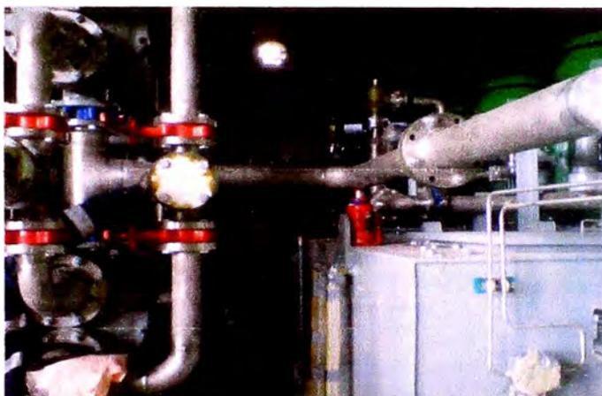
**Fig. 5.110 Sala de lubricación, a la izquierda intercambiador de calor, a la derecha skid principal, (Proyecto Antapaccay).**
