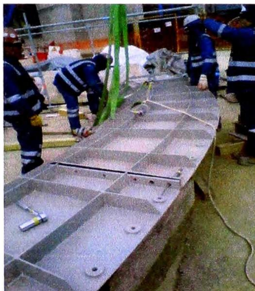
**Fig. 5.218 Ensamblado de tapa, (Proyecto Antapaccay).**
