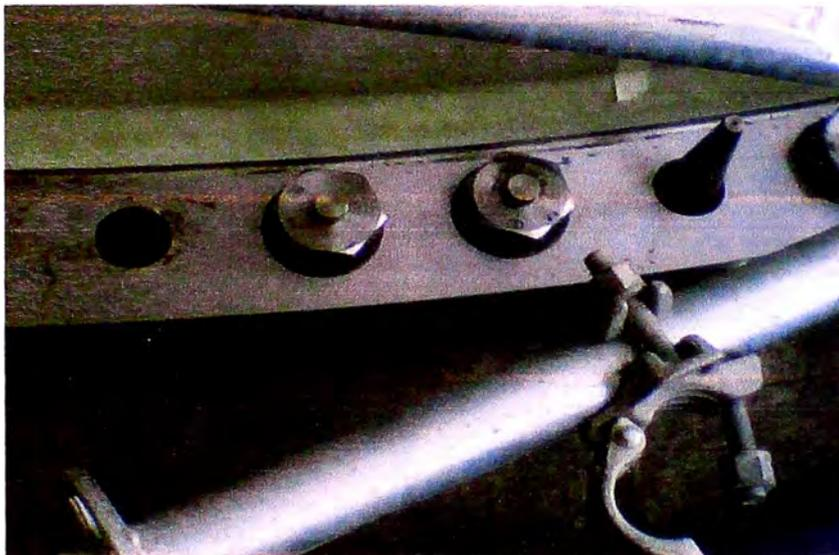
**Fig. 5.73 Instalación de pernos y pasador cónico, (Proyecto Antapaccay).**
