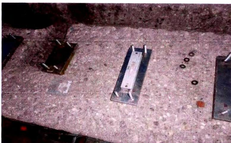
**Fig. 36 Verificación de nivelación de placas, mediante el uso de nivel de precisión, (Proyecto Antapaccay).**
