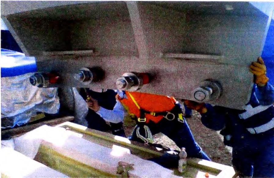
**Fig. 5.195 Colocación de pernos para montaje de segmento polar, (Proyecto Antapaccay).**
