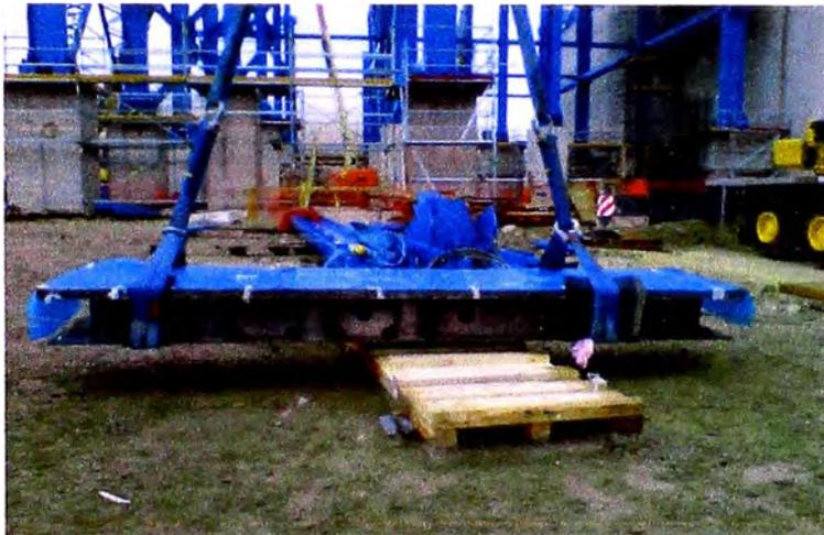
**Fig. 5.153 Izaje de soleplate de estator, (Proyecto Antapaccay).**
