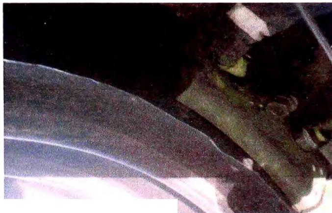
**Fig. 5.138 Montaje de corazas en trunnion liner, (Proyecto Antapaccay).**
