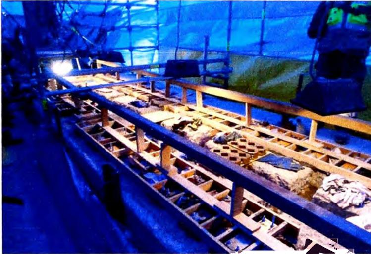
**Fig. 5.6 Encofrado de placas de nivelación, (Proyecto Antapaccay).**
