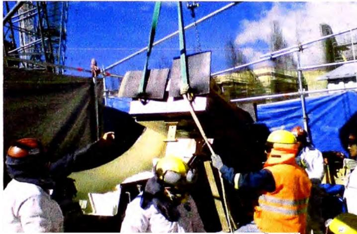
**Fig. 5.37 Montaje de cojines (Pads), (Proyecto Antapaccay).**
