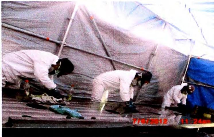
**Fig. 5.13 Limpieza de zona maquinada de soleplate, (Proyecto Antapaccay).**
