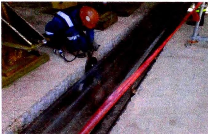
**Fig. 5.163 Alineamiento de pista de rodadura, (Proyecto Antapaccay).**
