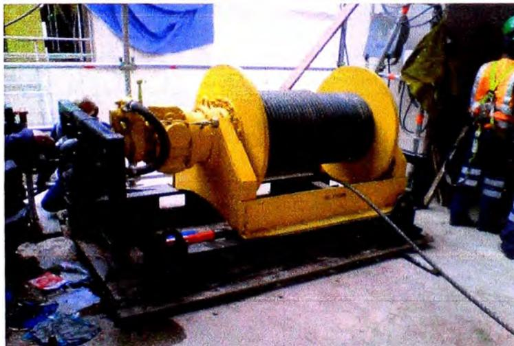
Fig. 4.2 Montaje de cabestrante (Proyecto Antapaccay).
