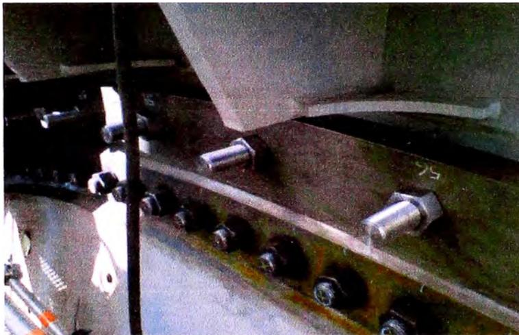
**Fig. 5.198 Colocación de pernos, (Proyecto Antapaccay).**
