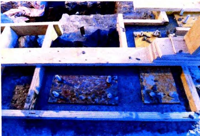
**Fig. 5.8 Grout en placas de nivelación, (Proyecto Antapaccay).**
