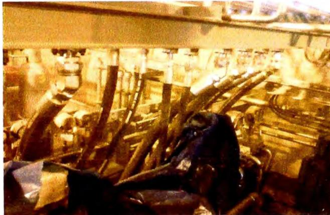
**Fig. 5.108 Conexiones flexibles desde manifold hacia tuberías inoxidables, (Proyecto Antapaccay).**
