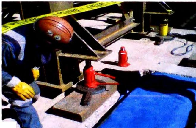
**Fig. 5.84 Elevación de cunas centrales y retiro de laines, (Proyecto Antapaccay).**
