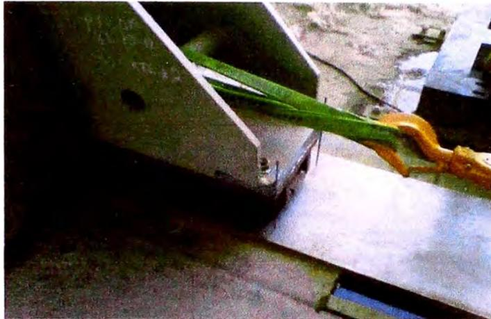
**Fig. 5.189 Colocación de tanquetas en ménsulas, (Proyecto Antapaccay).**
