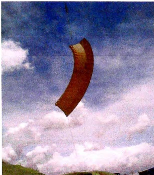
**Fig. 5.223 Izaje de tapa inferior de bobina lado de descarga, (Proyecto Antapaccay).**
