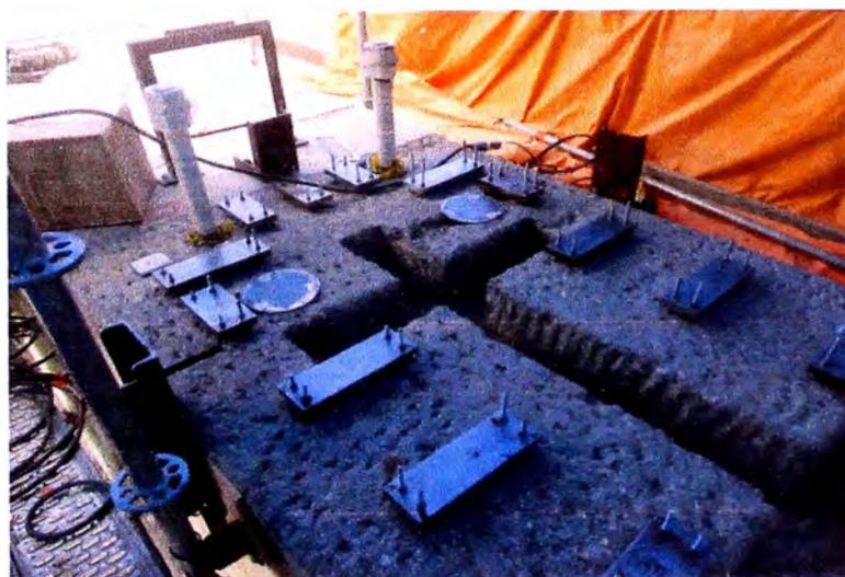
**Fig. 34** Instalación de placas de nivelación, (Proyecto Antapaccay).
