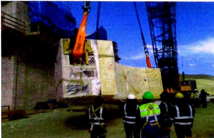
**Fig. 5.167 Descarga de estator, (Proyecto Antapaccay).**
