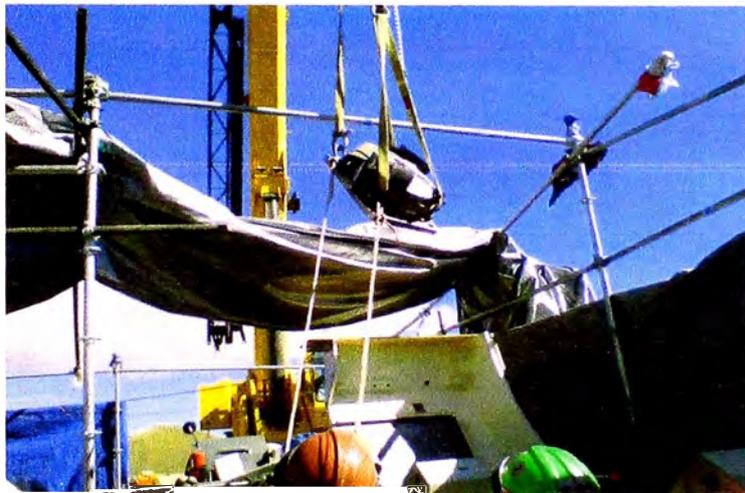
**Fig. 5.34 Montaje de gatos hidráulicos, (Proyecto Antapaccay).**
