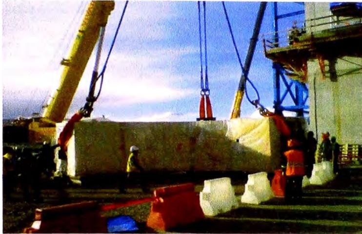
**Fig. 5.168 Colocación de maniobra de izaje para 1er tandem, (Proyecto Antapaccay).**
