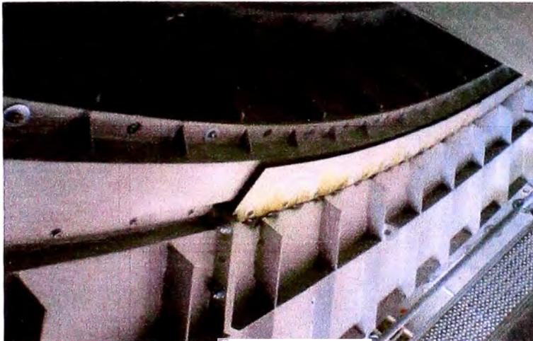
**Fig. 5.234** Instalación de protector de lluvia de perfil “L”, (Proyecto Antapaccay).
