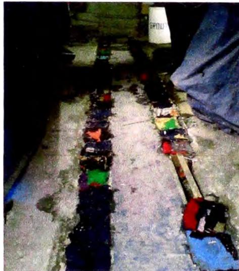
Fig. 5.165 Curado de grout en pista de rodadura, (Proyecto Antapaccay).
