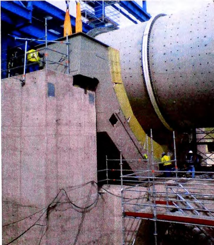
**Fig. 5.175 Montaje de los segmentos inferiores del estator, (Proyecto Antapaccay).**
