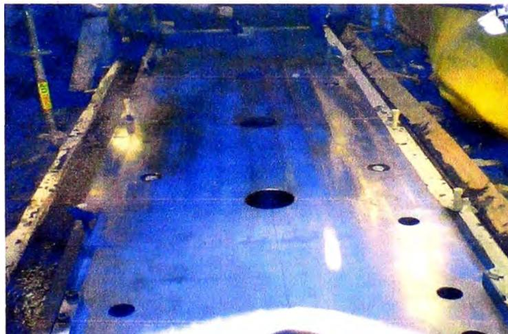
**Fig. 5.26 Termino de vaciado de grout epóxico, (Proyecto Antapaccay).**
