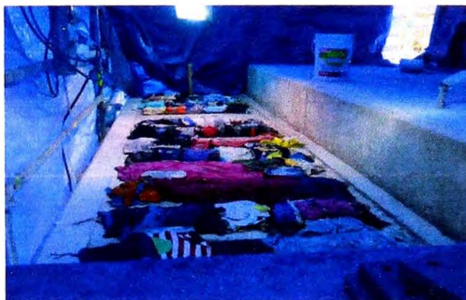
**Fig. 5.150 Curado de grout en placas de nivelación, (Proyecto Antapaccay).**
