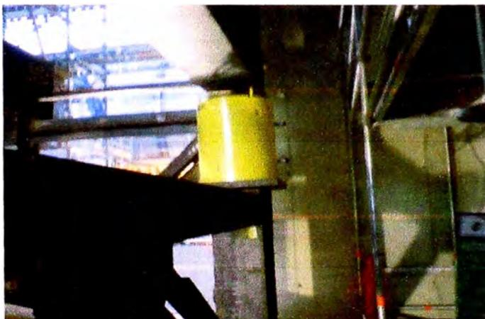
**Fig. 5.76 Montaje de gata hidráulica de 500 Ton, (Proyecto Antapaccay).**
