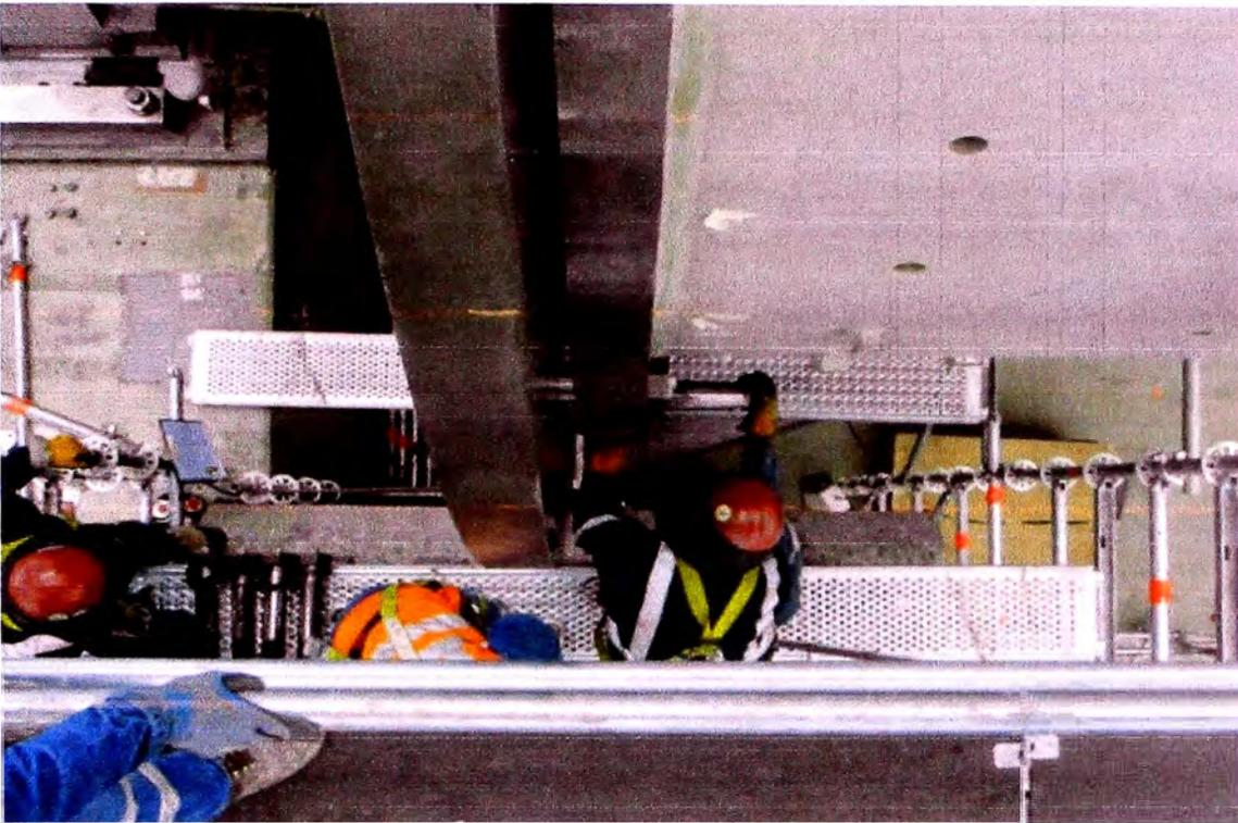
**Fig. 5.74** Instalación de pasador cónico, (Proyecto Antapaccay).
