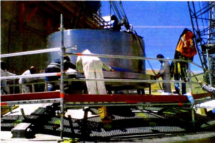
**Fig. 5.67 Montaje de trunnion, (Proyecto Antapaccay).**
