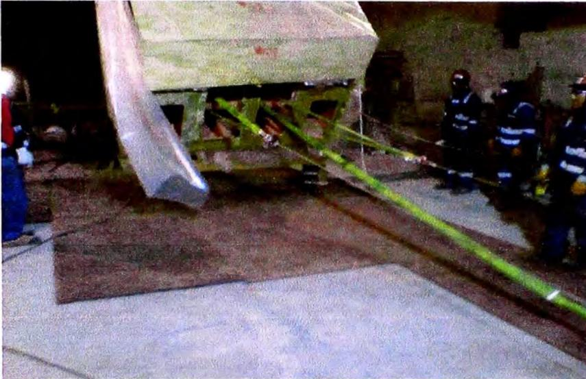
**Fig. 5.174 Colocación de maniobra para jalar el segmento inferior del estator, (Proyecto Antapaccay).**
