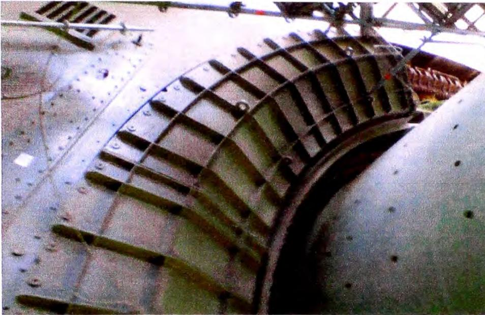
**Fig. 5.224 Montaje de tapa de bobina, (Proyecto Antapaccay).**
