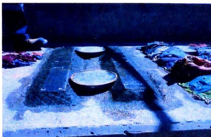
**Fig. 5.149 Grout cementicio placas de nivelación, (Proyecto Antapaccay).**
