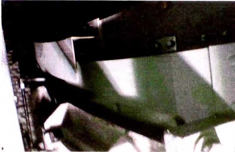
**Fig. 5.233** Instalación de protector de lluvia de perfil “Z”, (Proyecto Antapaccay).
