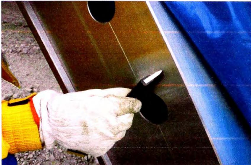
**Fig. 5.49 Verificación de limpieza en flanges de shells, (Proyecto Antapaccay).**
