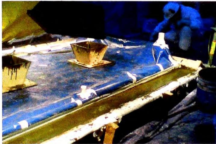
**Fig. 5.25 Grout epóxico en Solplate, (Proyecto Antapaccay).**
