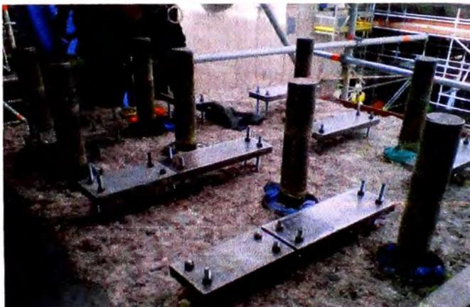
Fig. 5.93 Instalación de placas de nivelación de frenos, (Proyecto Antapaccay).
