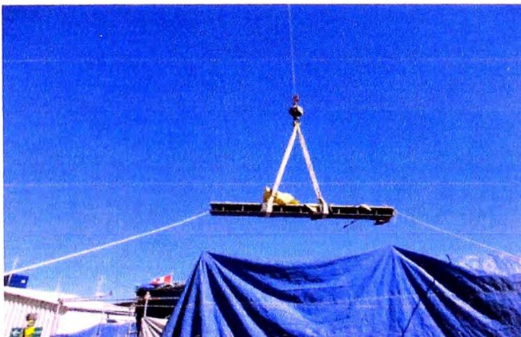
**Fig. 5.160 Izaje de pista de rodadura, (Proyecto Antapaccay).**
