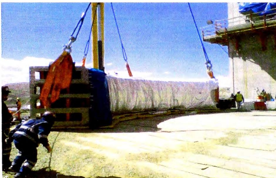
**Fig. 5.176 Maniobra para 1er tandem de segmento superior, (Proyecto Antapaccay).**
