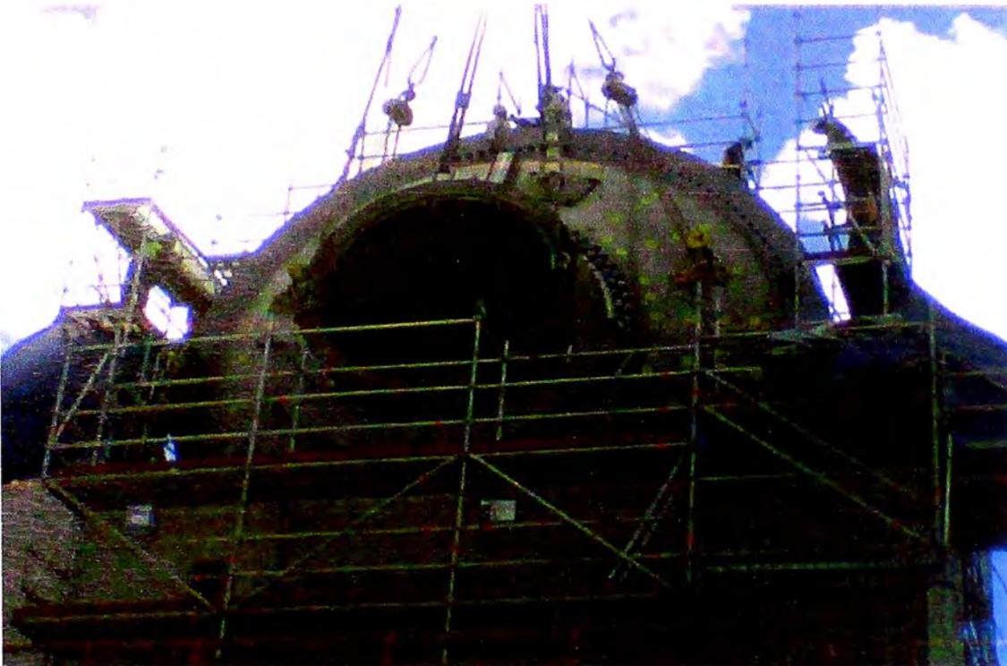
**Fig. 5.75** Montaje de tapa-trunnion, (Proyecto Antapaccay).
