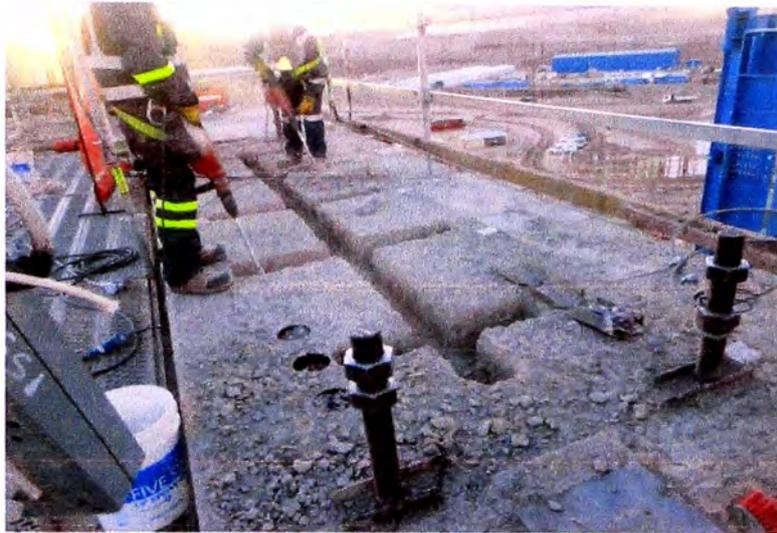
**Fig. 5.1** Escarificado de la fundación del molino bolas, (Proyecto Antapaccay).
