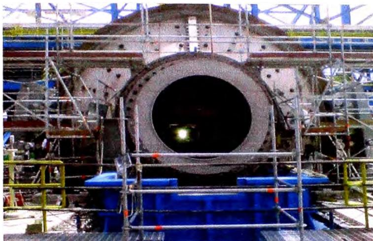
**Fig. 5.143 Montaje de trunnion magnético, (Proyecto Antapaccay).**
