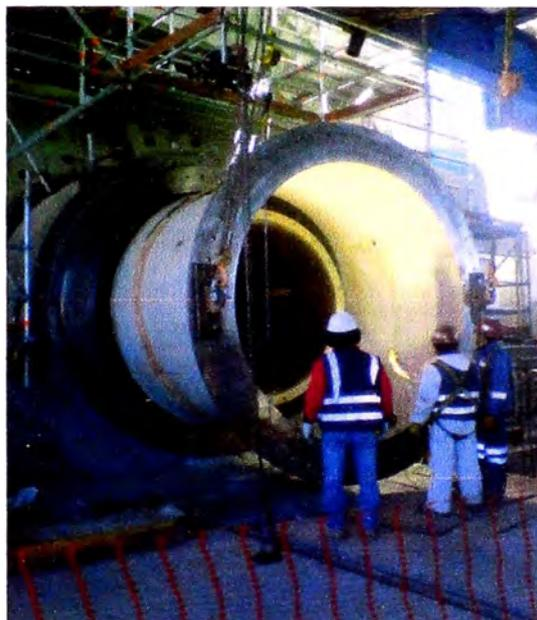
**Fig. 5.130 Aproximación de trunnion liner al interior del molino, (Proyecto Antapaccay).**
