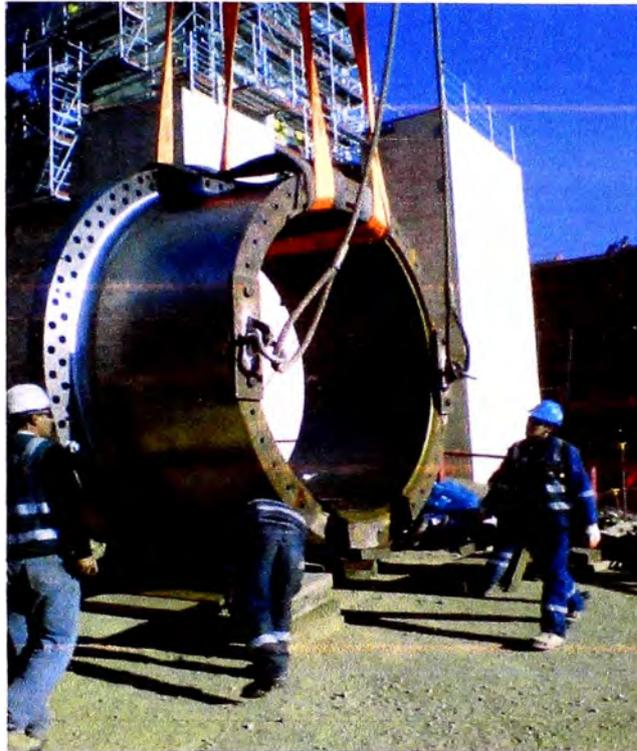
**Fig. 5.60** Instalación de estrobos en orejas de izaje, (Proyecto Antapaccay).
