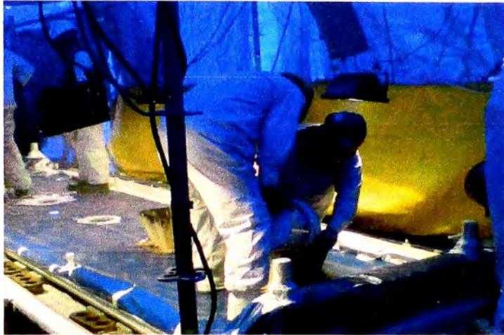
**Fig. 5.24 Vaciado de Grout epóxico, (Proyecto Antapaccay).**
