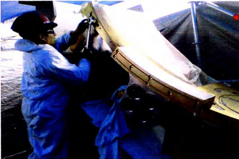
**Fig. 5.42 Instalación de rieles de empuje, (Proyecto Antapaccay).**
