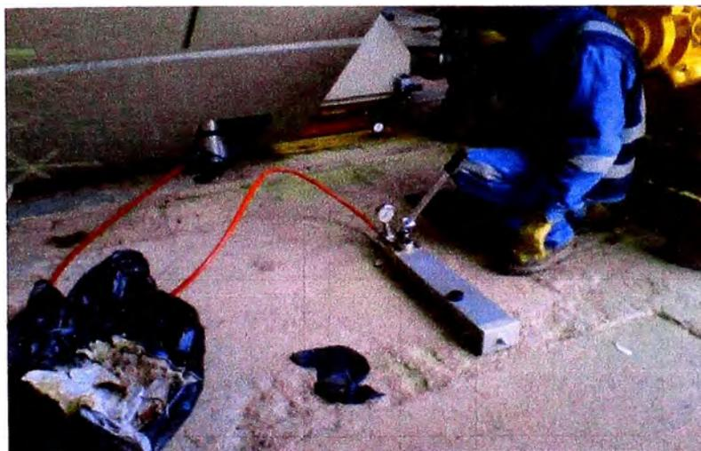
**Fig. 5.188 Colocación de gatas hidráulicas, (Proyecto Antapaccay).**
