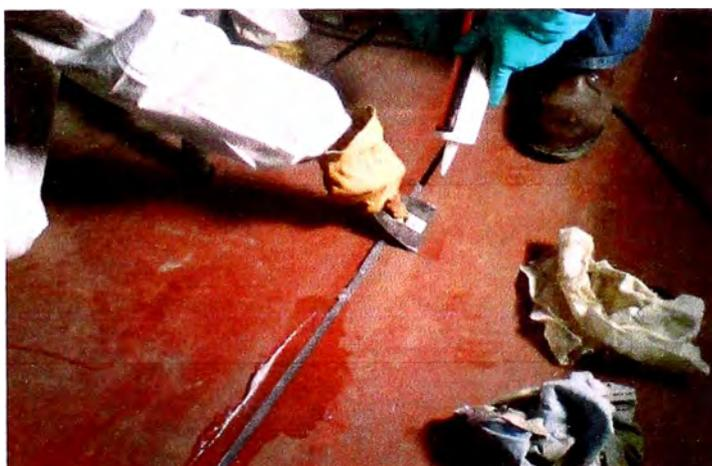
**Fig. 5.115 Aplicación de silicona en empalmes de shells, (Proyecto Antapaccay).**
