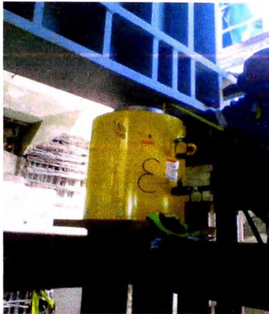
**Fig. 5.83 Control de elevación del pistón de las gatas, (Proyecto Antapaccay).**
