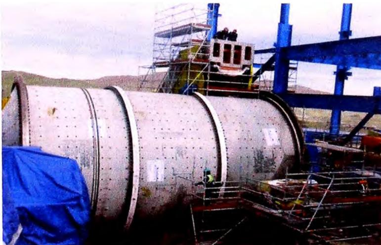
**Fig. 5.183 Soporte y montaje de 01 segmento superior, (Proyecto Antapaccay).**
