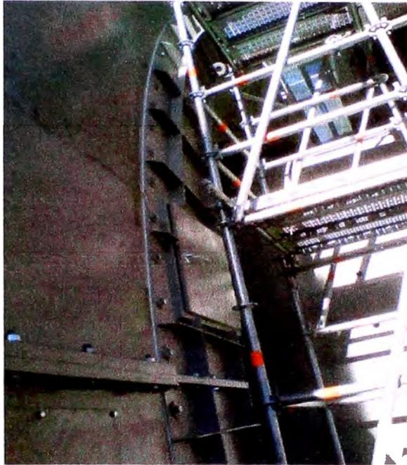
**Fig. 5.222 Montaje de tapa superior de bobina lado de alimentación, (Proyecto Antapaccay).**
