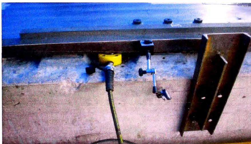
**Fig. 5.19 Nivelación de soleplate y soporte para alineamiento de soleplate, (Proyecto Antapaccay).**
