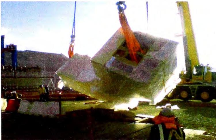
**Fig. 5.169 Inicio de volteo de segmento inferior de estator, (Proyecto Antapaccay).**
