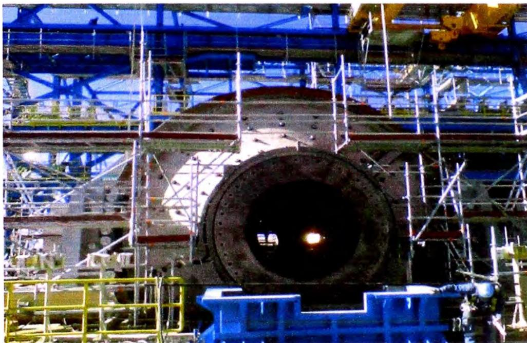
**Fig. 5.134** Montaje de trunnion liner, (Proyecto Antapaccay).
