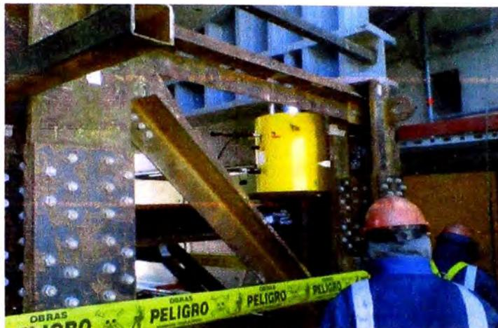
**Fig. 5.86 Elevación de molino mediante gatas, (Proyecto Antapaccay).**
