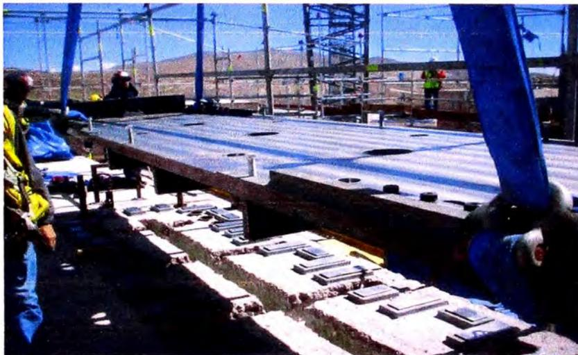
**Fig. 5.16 Montaje de soleplate, (Proyecto Antapaccay).**
