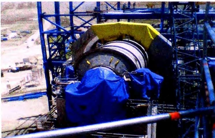
**Fig. 5.186 Montaje de estator, (Proyecto Antapaccay).**
