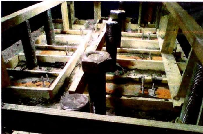
**Fig. 5.94 Grout cementicio en placas de nivelación, (Proyecto Antapaccay).**
