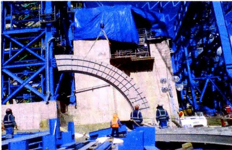
**Fig. 5.221** Izaje de tapa superior de bobina lado de alimentación, (Proyecto Antapaccay).
