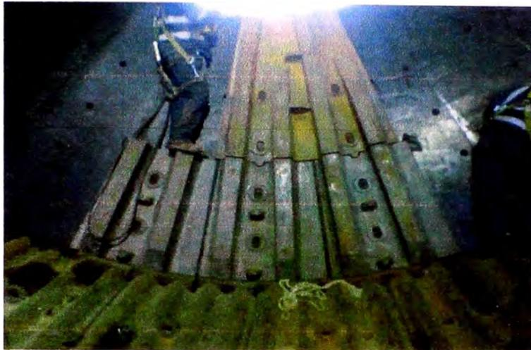
**Fig. 5.123 Montaje de 01 coraza inner head, (Proyecto Antapaccay).**
