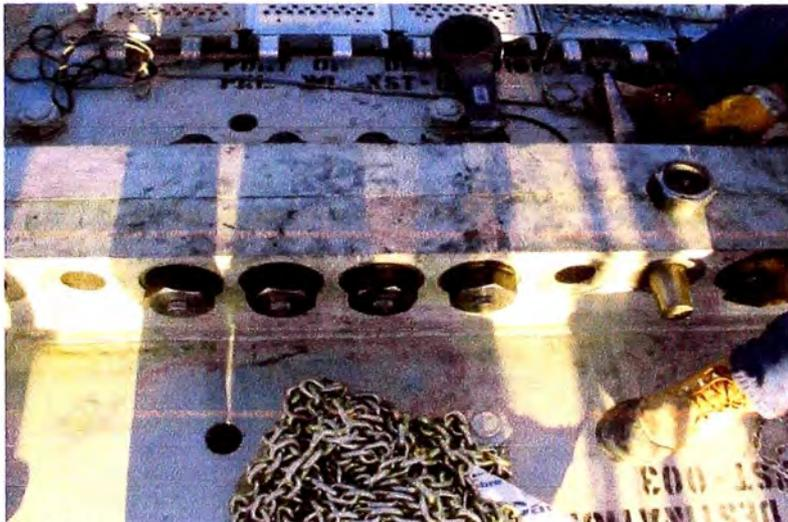
**Fig. 5.58 Instalación de pasador cónico y pernos SPC-4, (Proyecto Antapaccay).**
