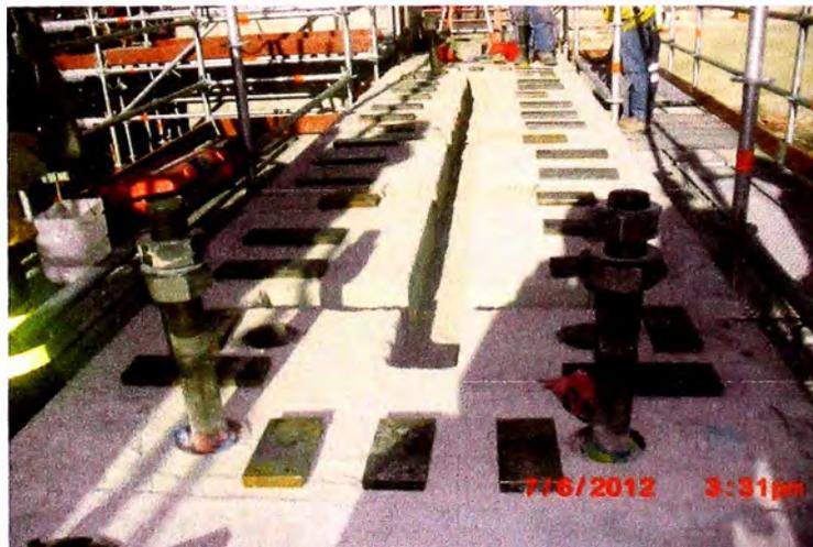
**Fig. 33** Distribución de placas de nivelación, (Proyecto Antapaccay).
