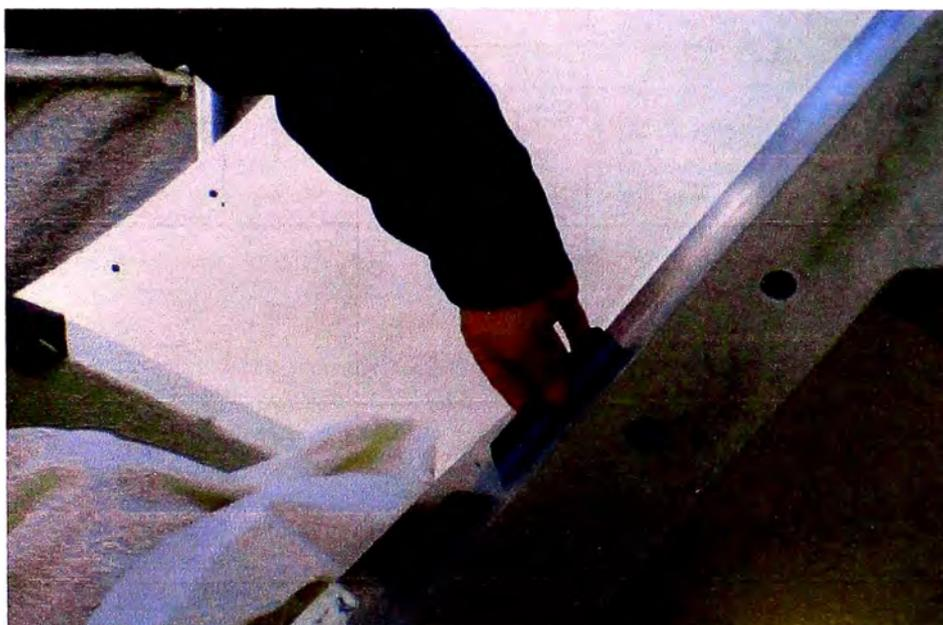
Fig. 5.29 Verificación de planicidad utilizando regla de pelo, (Proyecto Antapaccay).
