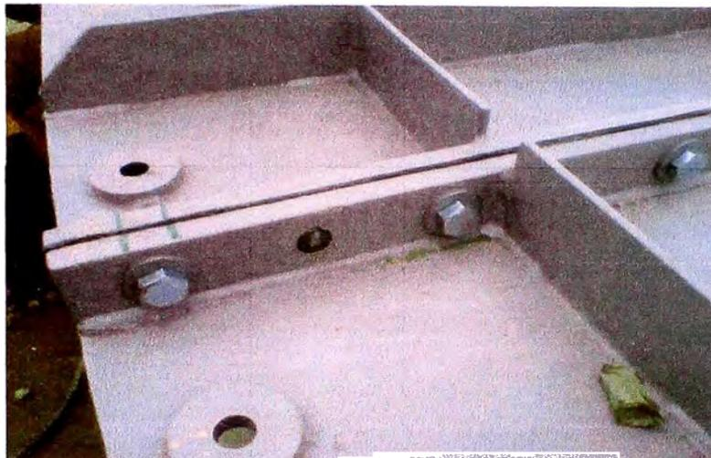
**Fig. 5.219 Colocación de pin y pernos, (Proyecto Antapaccay).**
