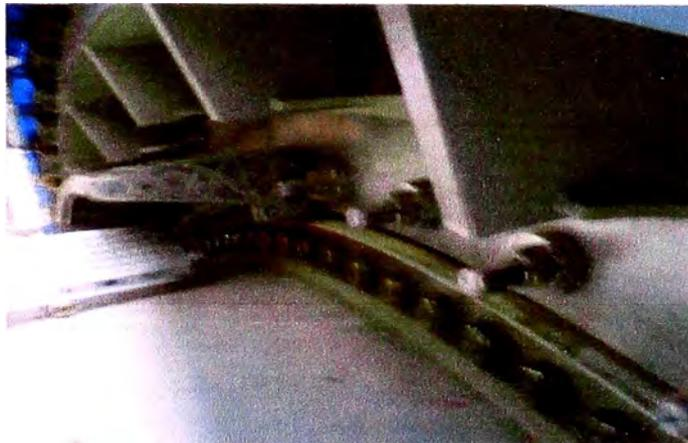
**Fig. 5.212 Montaje de anillo rozante, (Proyecto Antapaccay).**
