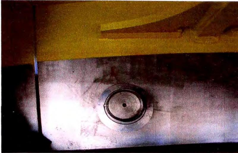
**Fig. 5.203 Colocación de pines de fijación, (Proyecto Antapaccay).**
