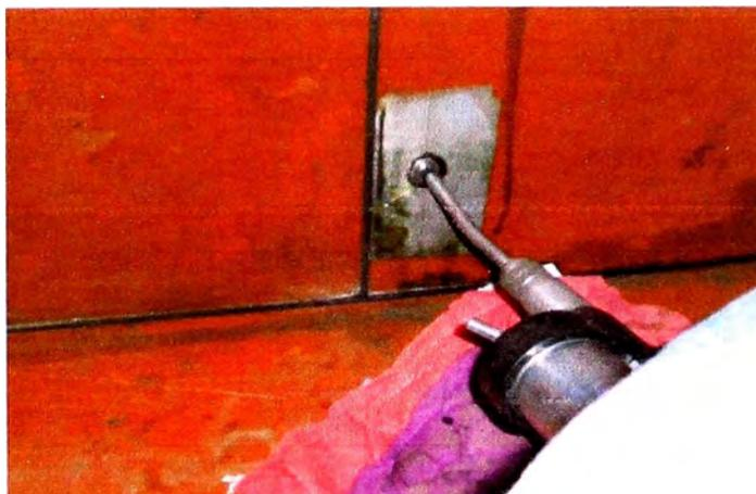
**Fig. 5.114 Conexión de pistola de engrase en el puerto de inyección inferior, (Proyecto Antapaccay).**
