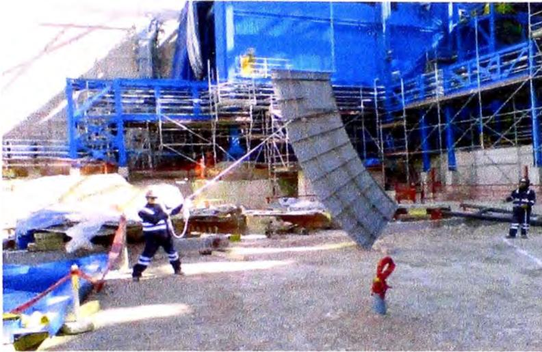
**Fig. 5.220** Izaje de tapa inferior de bobina lado de alimentación, (Proyecto Antapaccay).
