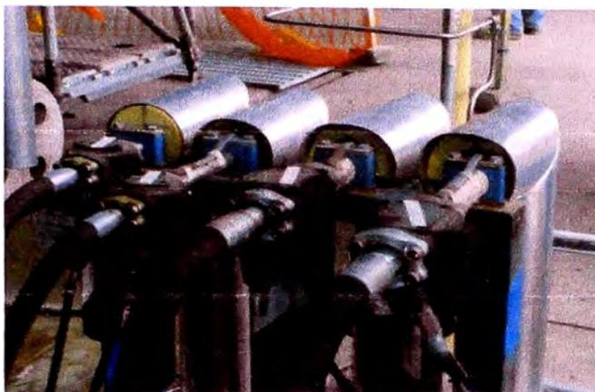
**Fig. 5.109 Conexiones flexibles desde filtros hacia cojinetes, (Proyecto Antapaccay).**
