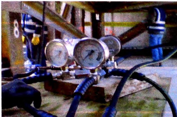
**Fig. 5.78 Manifold y manómetros (control de presión en gatas), (Proyecto Antapaccay).**
