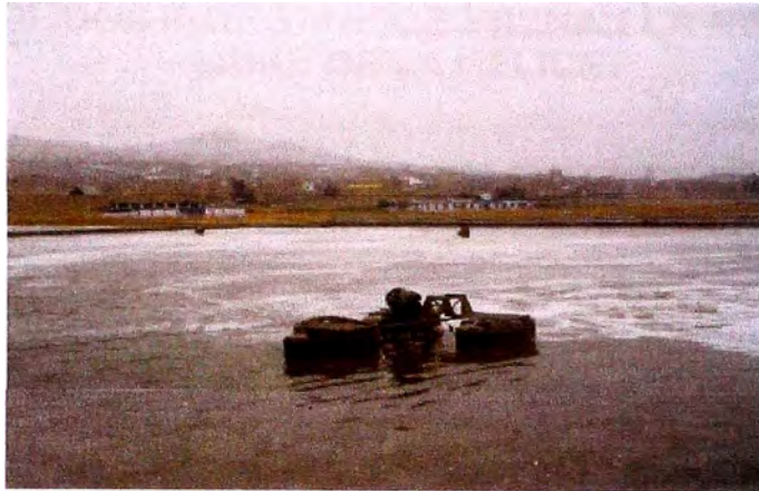
FIG 4.1 Aereador 15 hp- aire O 2 laguna LAMP - PTAR SAN JUAN
