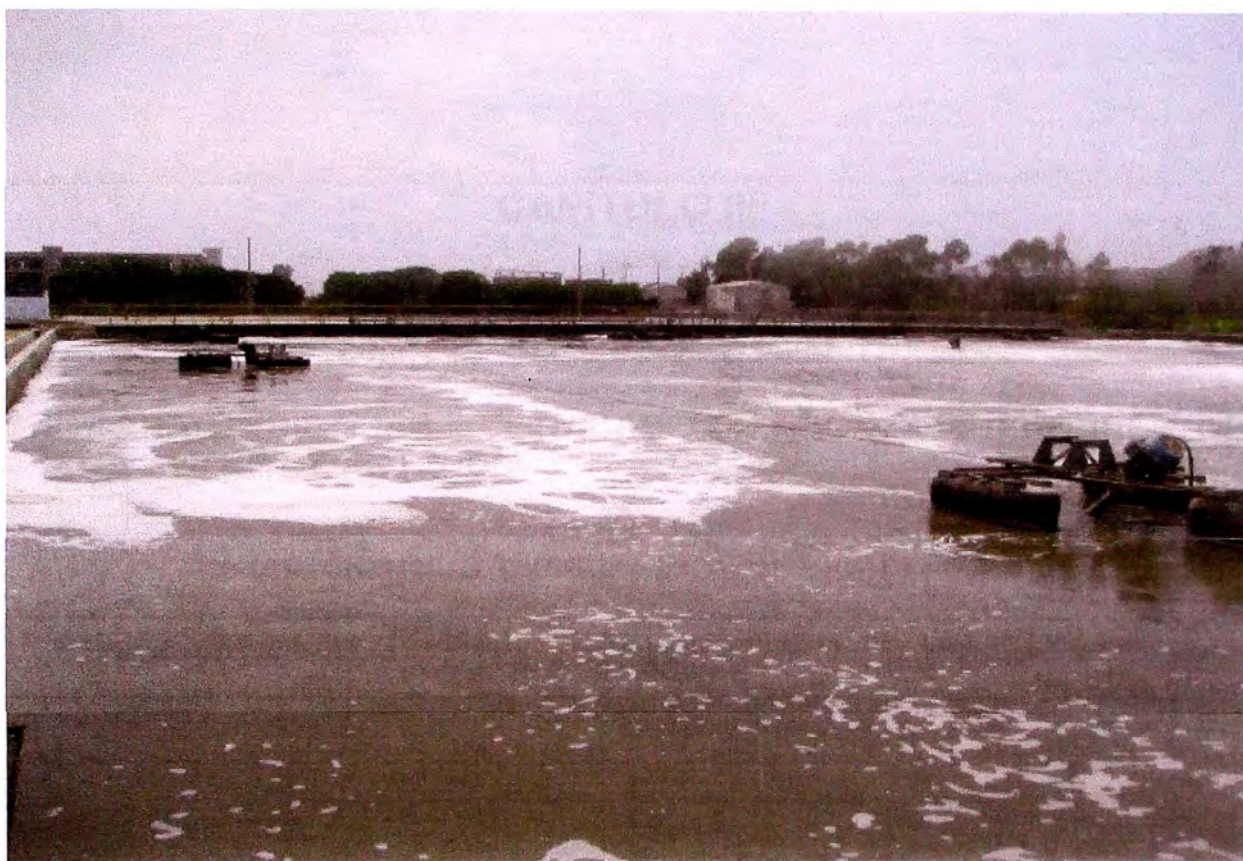
Fig. 2.16 Laguna de tratamiento biológico aerobio LAMC 2 - PTAR HUASCAR
