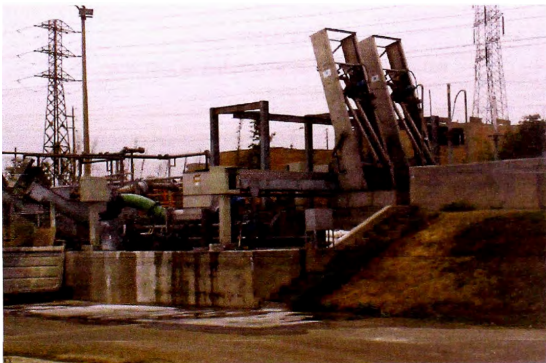
Fig. 2.6. Unidad de pre-tratamiento – PTAR SAN JUAN
