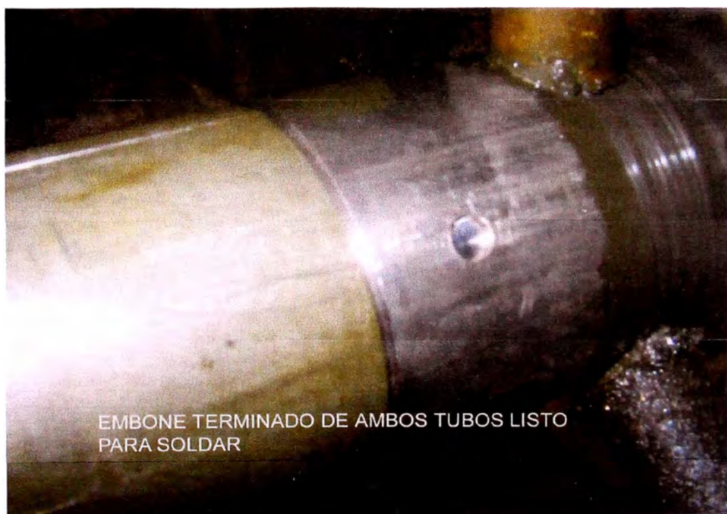
Figura 4.8. Embone terminado de ambos tramos de tubo listos para soldar
