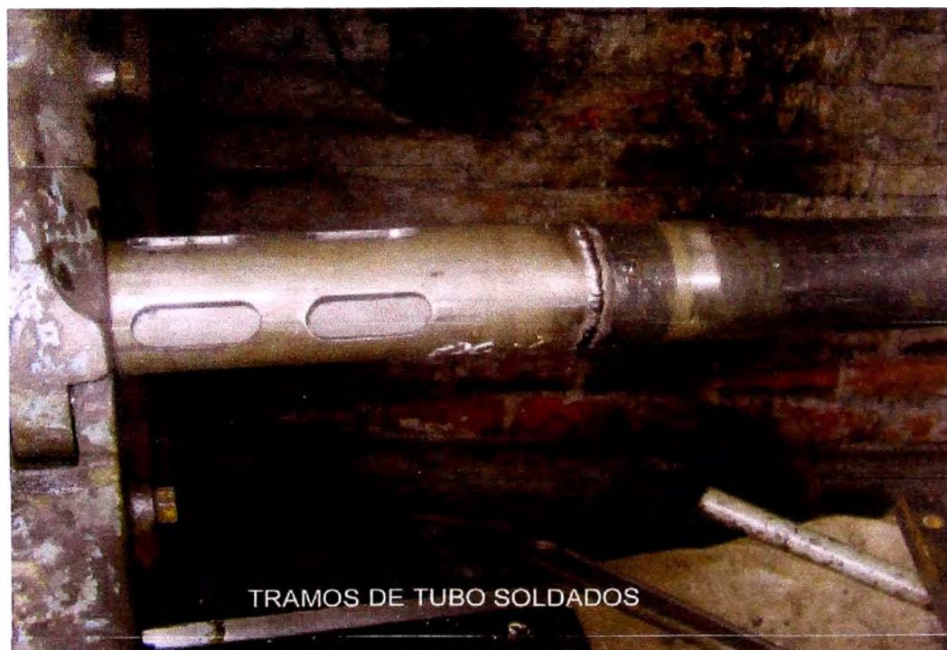
Figura 4.10 Tramos de tubos soldados
