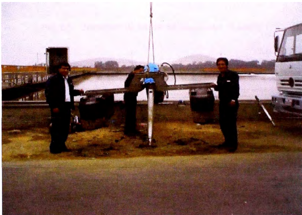
Fig. 5.4. Puesta del aerador de 20 HP a la laguna LAMC 2-1
