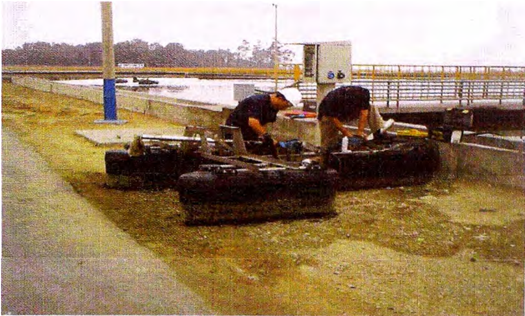
Fig. 5.3. Ensamble del eje recuperado al aerador 20 HP
