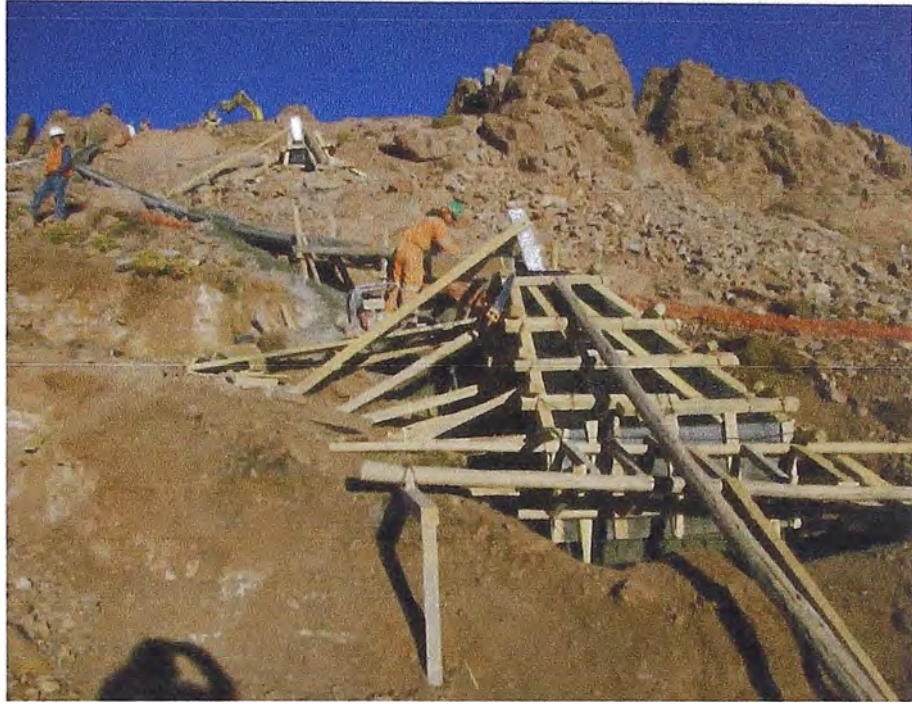
Figura 2.5 Trabajos de hormigonado de zapatas
