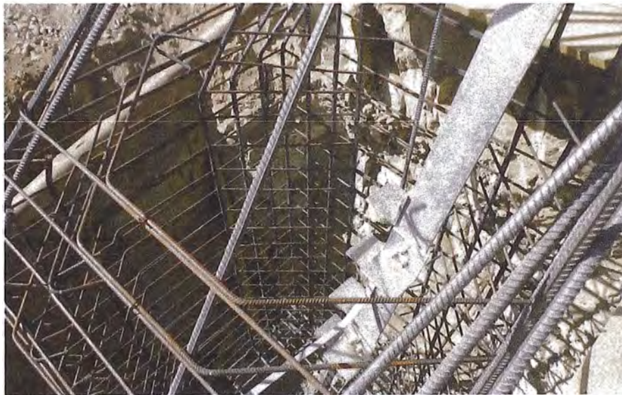
Figura 2.4 Trabajos de nivelación de stubs y enfierradura
