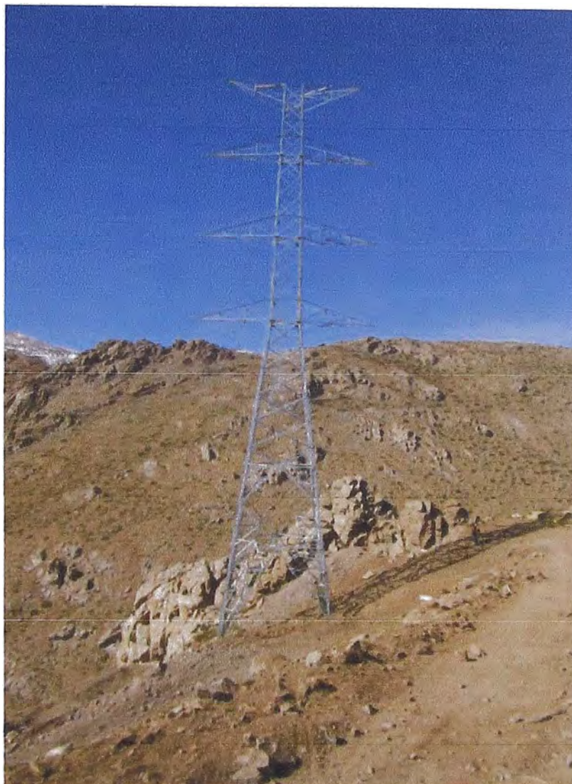
Figura 2.7 Torre de anclaje
