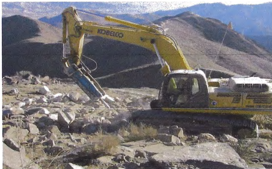
Figura 5.12 Excavadora marca Kobelco modelo 24 H
