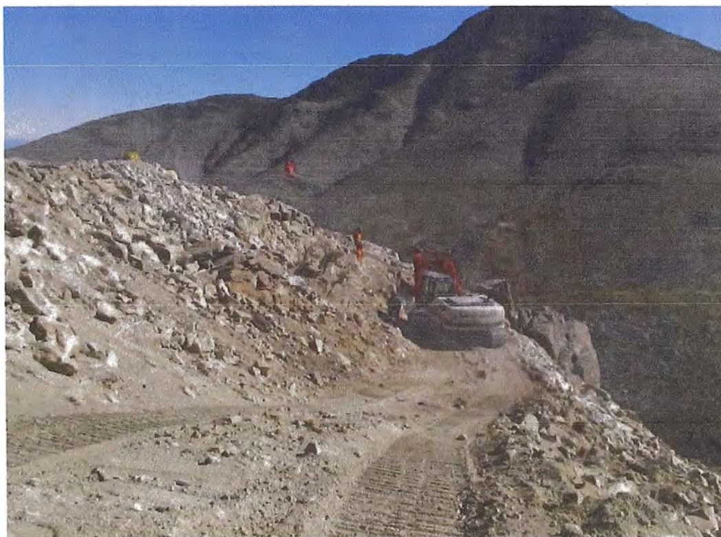
Figura 2.2 Movimiento de tierras para los accesos a las torres
