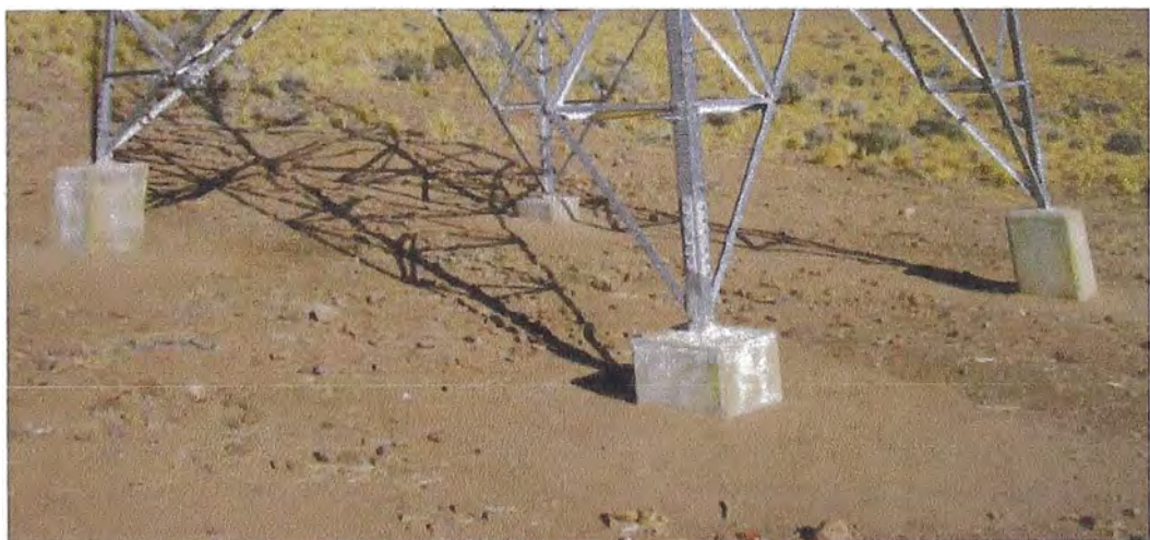
Figura 2.6 Relleno de fundaciones
