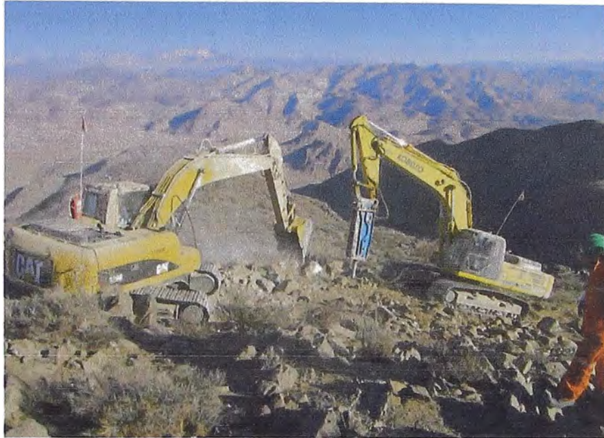
Figura 2.3 Excavación de las fundaciones
