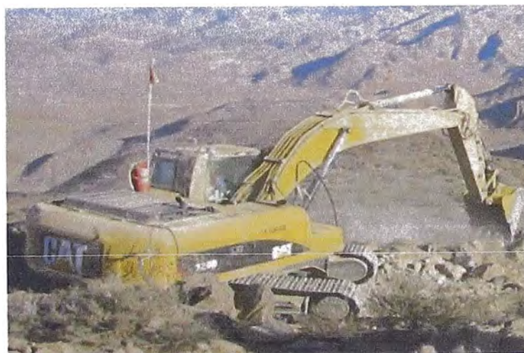
Figura 5.6 Excavadora con balde marca Catarpiller modelo 320D
