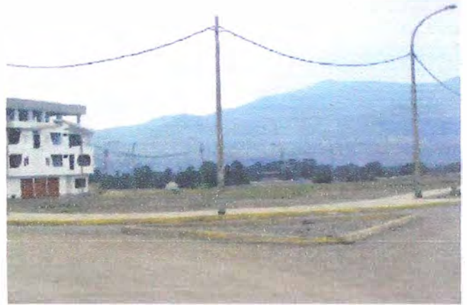
Figura N° 70: San Carlos (4)- Av San Carlos y Ca B
