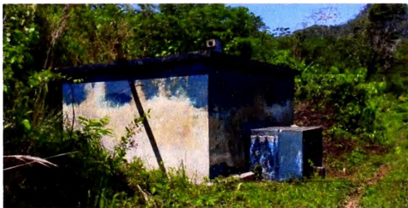
FOTOGRAFÍA N° 4.5: Vista actual del reservoirio existente.
