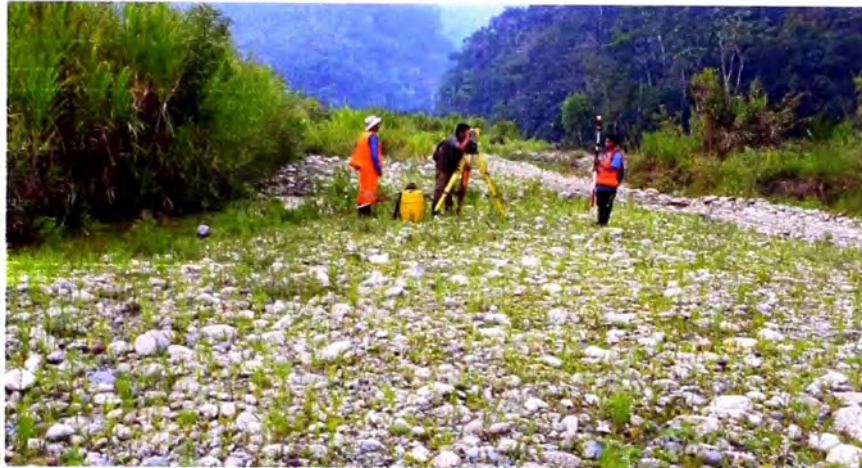
FOTOGRAFÍA N° 3.1: Fotografía del levantamiento topográfico al borde del río Chichireni.
