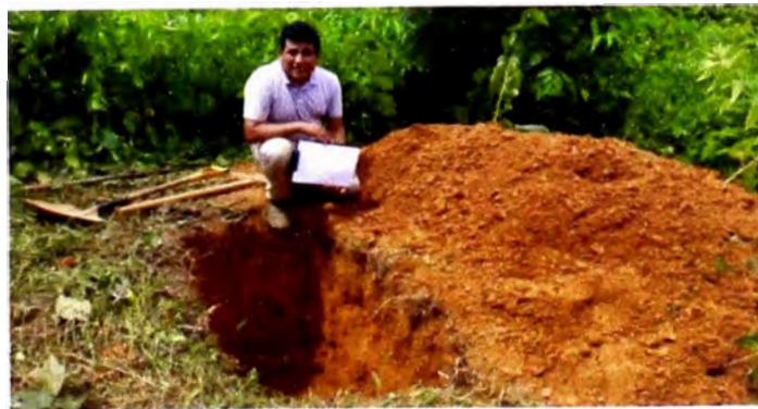
FOTOGRAFÍA N° 3.5: Calicata ubicada en el área del reservorio proyectado
