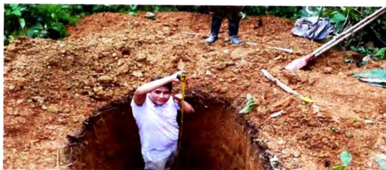
FOTOGRAFÍA N° 3.6: Calicata ubicada en el área de la PTAR
