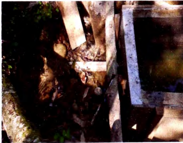
a) Ingreso del agua a la estructura
