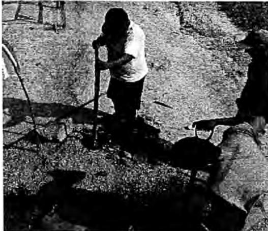
**FOTOGRAFÍA N° A.18:** Excavación y llenado de concreto en los vértices
