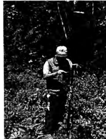
**FOTOGRAFÍA N° A.19:** Trazado de la línea de aducción con GPS diferencial
