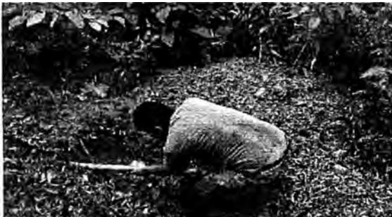
**FOTOGRAFÍA N° A.27:** Excavación de la calicata N°01 - Reservorio
