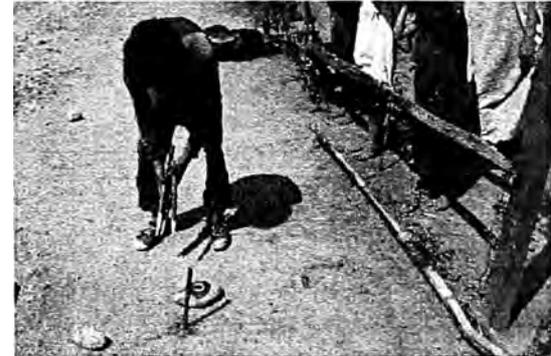
**FOTOGRAFÍA N° A.17:** Colocación de estacas para los vértices del polígono
