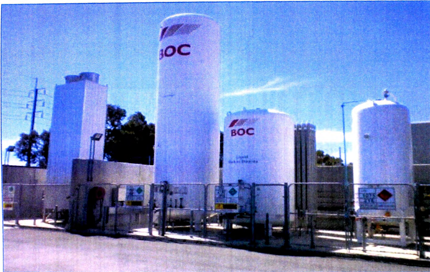
Figura 4.9 Infraestructura mínima, cerco, puerta de acceso, avisos de seguridad.
