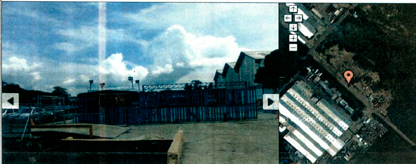
Figura: Vista Frontal de la Planta AJEVEN C.A., lugar donde se tomó la fotografía.
