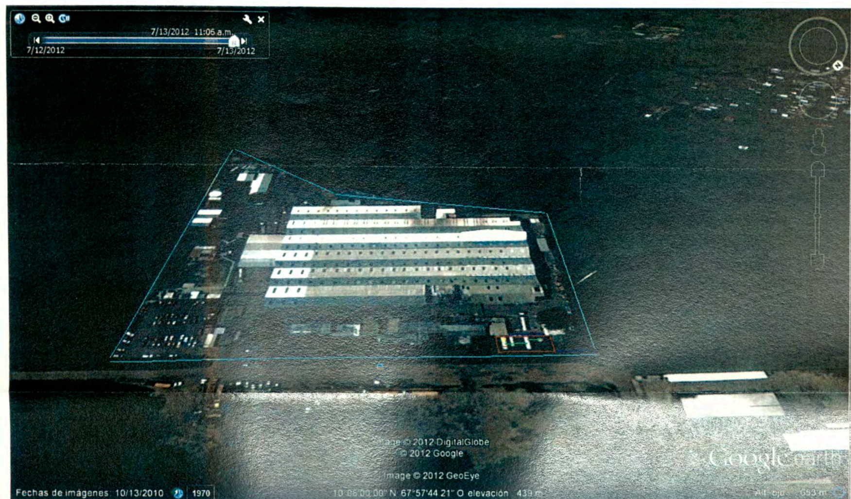
Figura: Vista panorámica de la Planta AJEVEN C.A., ubicada en un parque agroindustrial, con el horizonte agrícola y forestal
