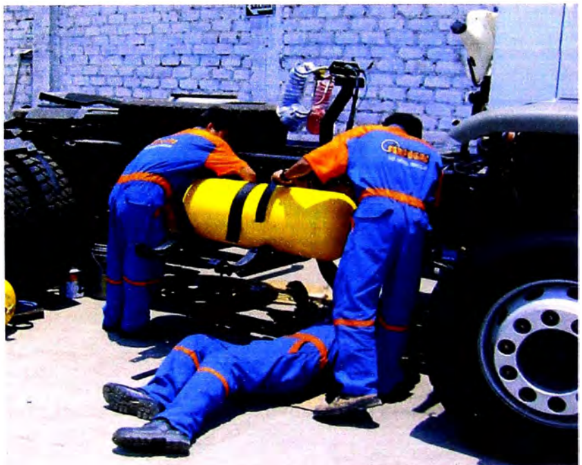
Foto 3.20. Instalación de los Tanques
