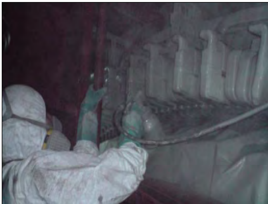
Figura 6. 54: Aplicación del barniz protector en las diferentes partes que conforman el estator
