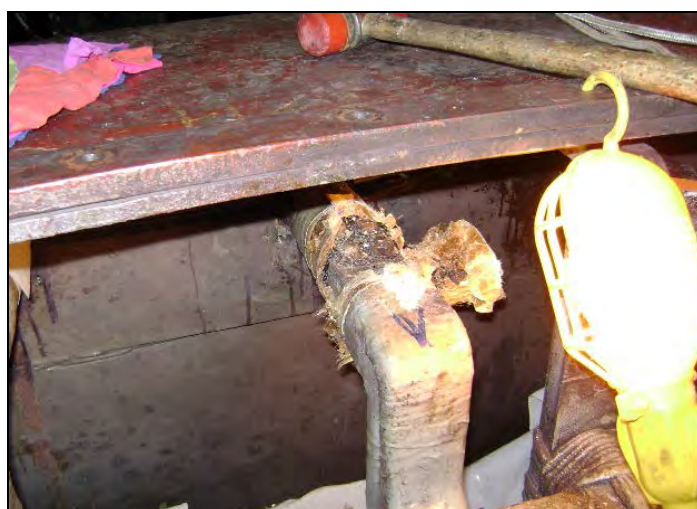
Figura 6. 16: Retirando el aislamiento deteriorado
