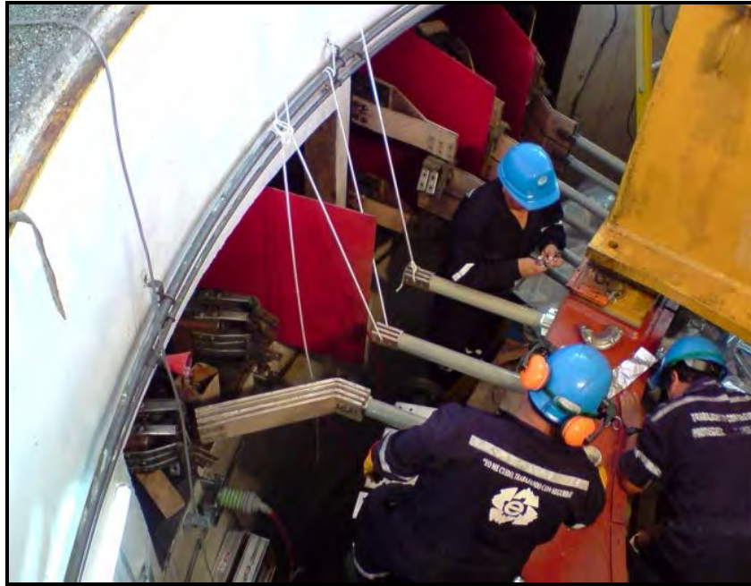
Figura 6. 32: Realizando la conexión del imbricado doble del devanado del estator
