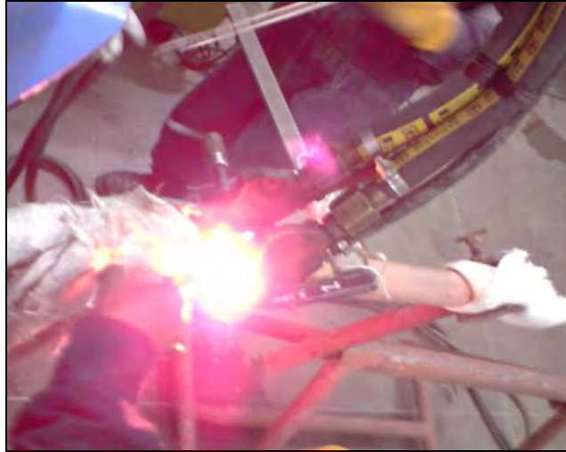
Figura 6. 23: Rellenado de la perforación de la barra con silfos
