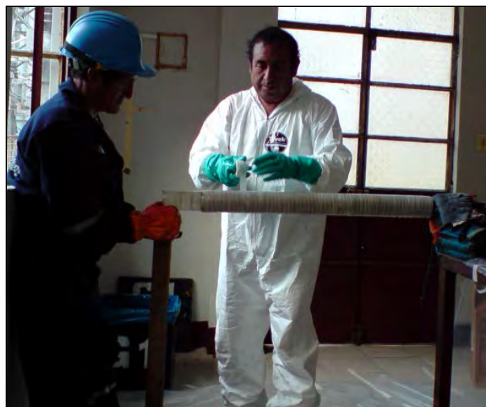
Figura 6. 28: Encintado de la barra reparada
