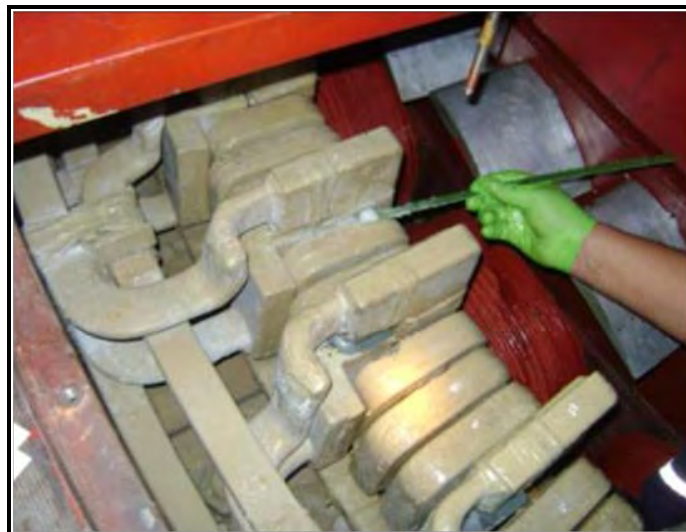
Figura 6. 51: Aplicación de la resina en las zonas afectadas
