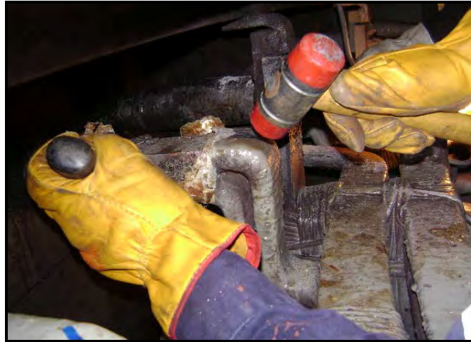
Figura 6. 17: Retirando el aislamiento deteriorado
