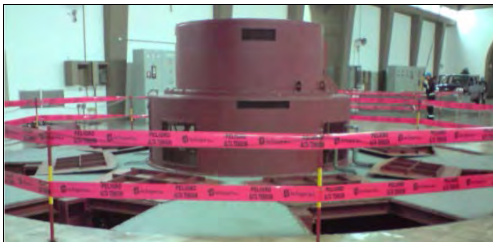
Figura 6. 44: Retiro de las planchas estrilladas
