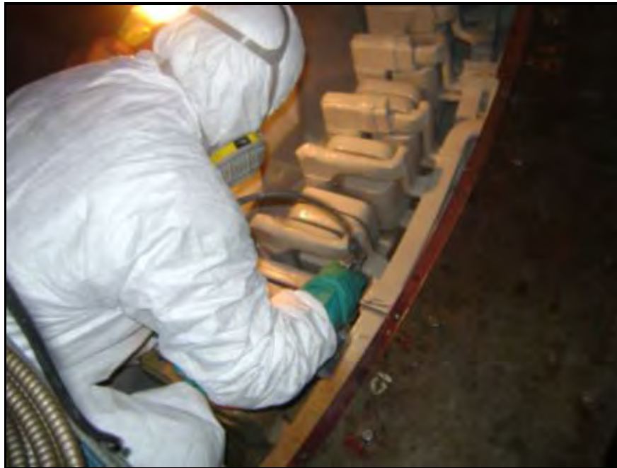
Figura 6. 53: Aplicación de la pintura semiconductora en los cabezales superiores
