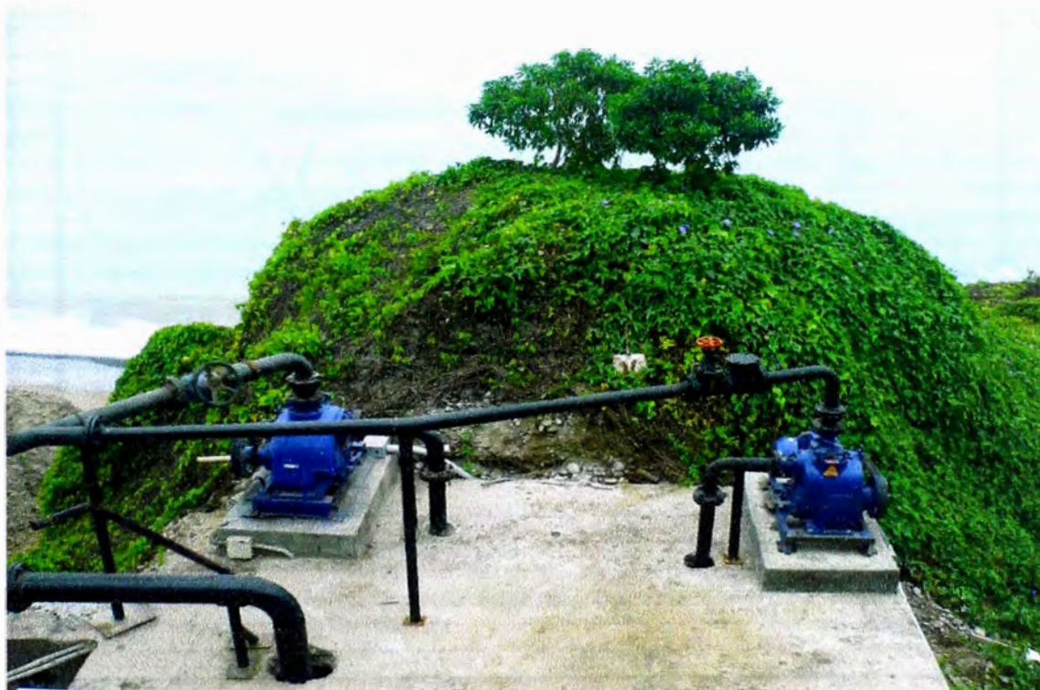
Foto 4.2: Instalación de bombas centrifugas.
