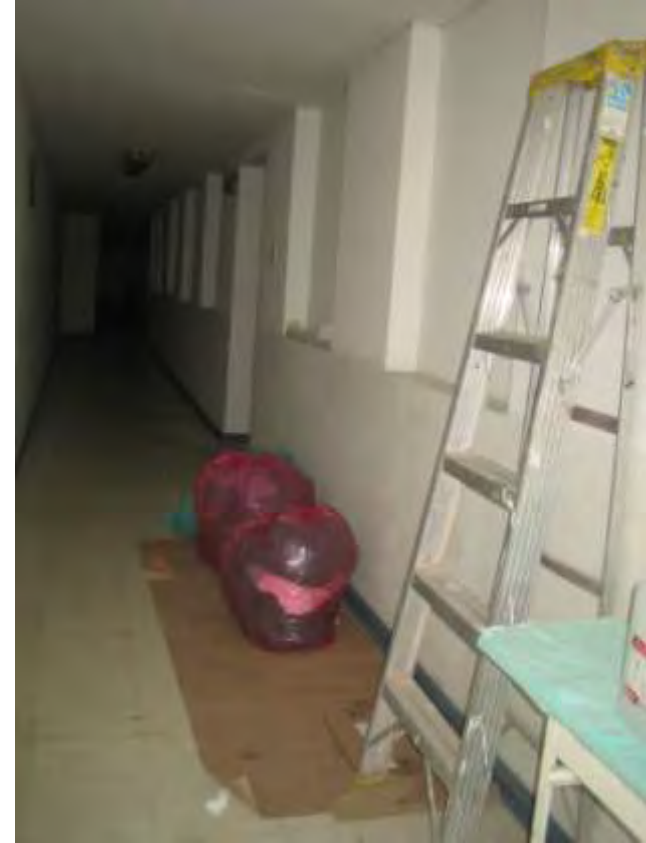
FOTO N° 10 - INADECUADA UBICACIÓN PARA EL ALMACENAMIENTO INTERMEDIO DE RESIDUOS SÓLIDOS EN LOS SERVICIOS EL HMC
