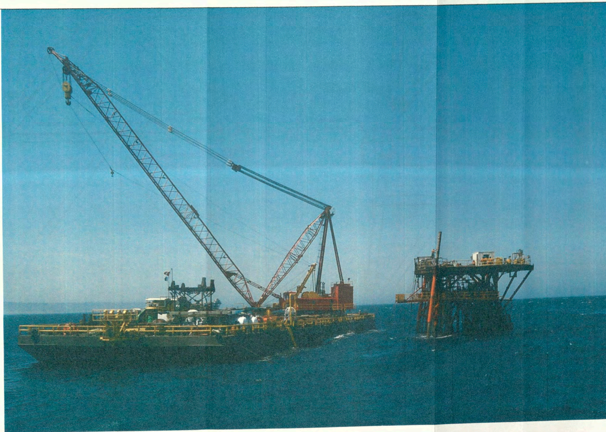
Figura 1.3 Vista mostrando una reparación de jacket con el apoyo de una nave tipo "work barge"
