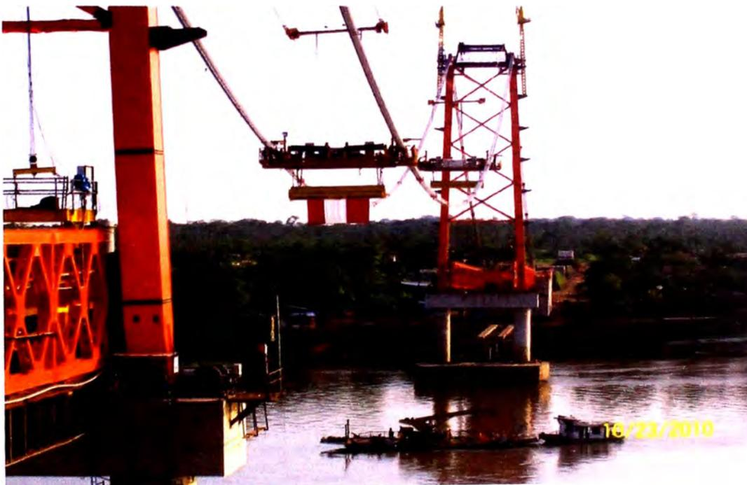
Figura 4.56 PLATAFORMA HOIST MONTAJE DE PÉNDOLAS
