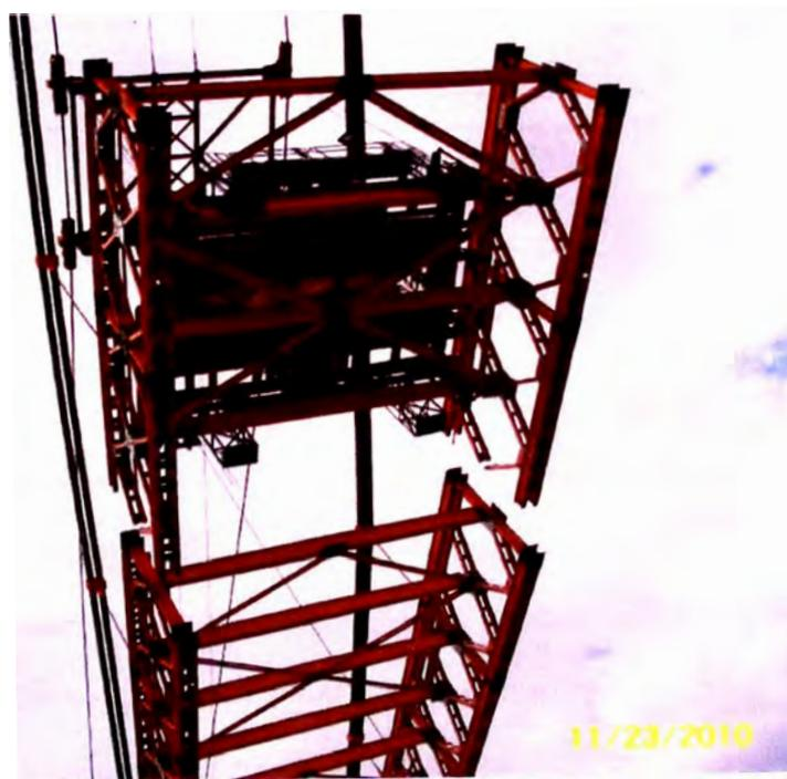
Figura 4.62 ALINEAMIENTO DE MÓDULOS PARA INTERCONEXIÓN
