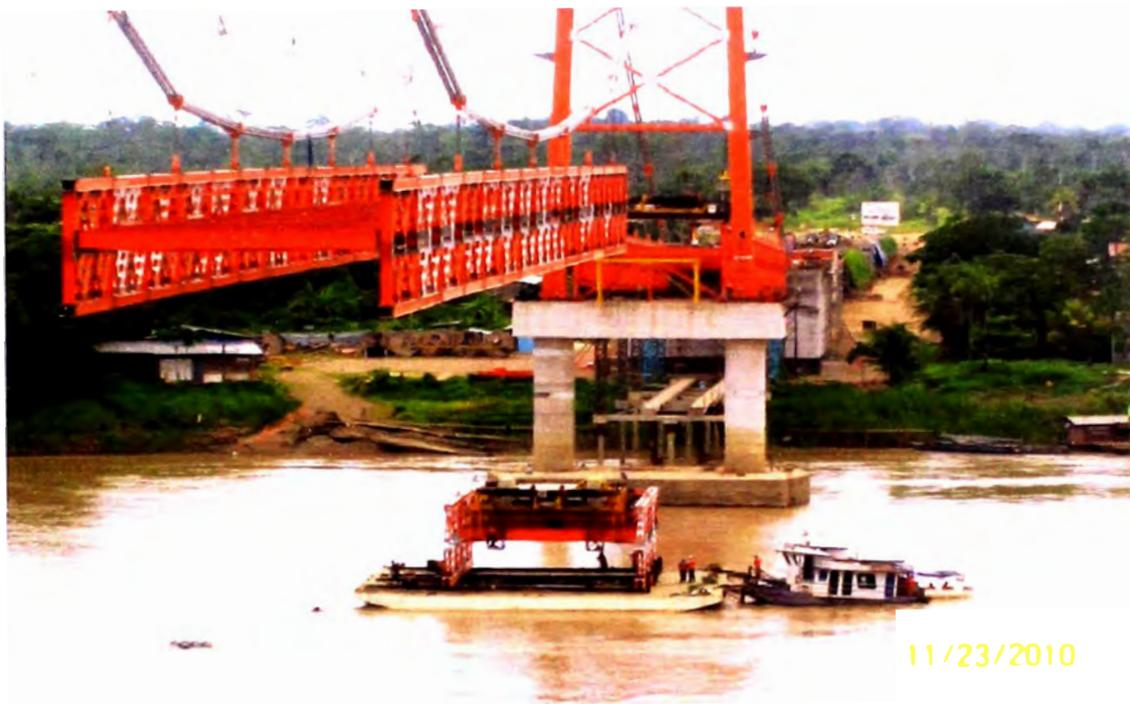
Figura 4.61 MONTAJE DE MÓDULOS
