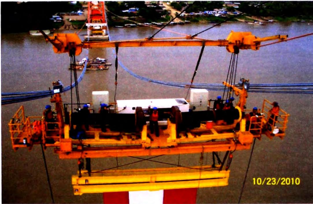
Figura 4.55 PLATAFORMAS HOIST MONTAJE DE PÉNDOLAS
