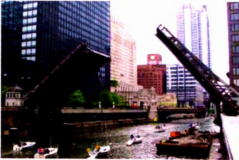
Figura 2.10 PUENTE BASCULANTE
