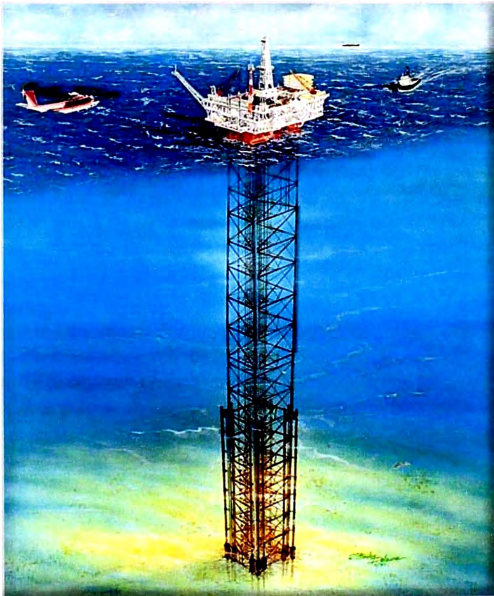
Fig. 3.2 Muestra la disposición de una Plataforma Flexible (Se puede ver su base reforzada, la cual será resistente a la Flexión)
