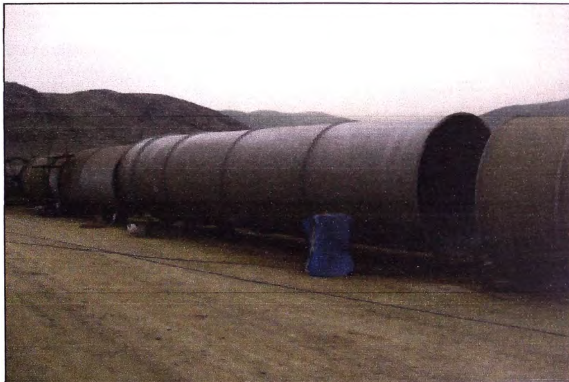
Figura 5.2: Preensamble de tramo A7
