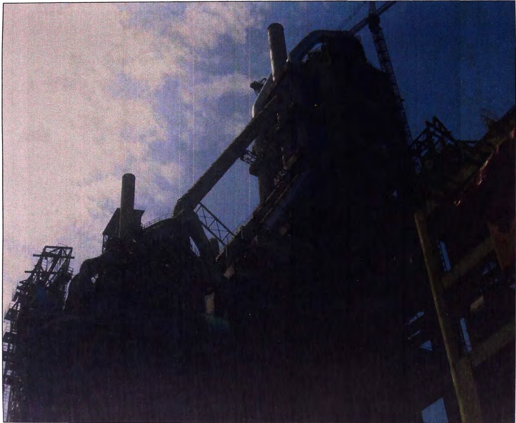
DUCTOS B4, B2, A9 (LADO OESTE)
