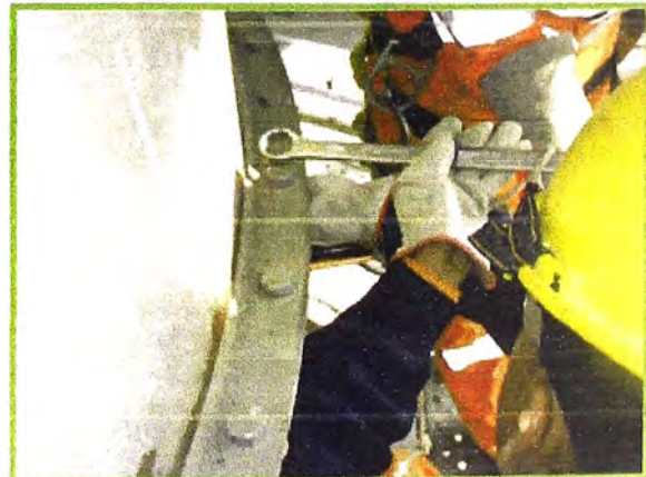
INSPECCION DEL TORQUE DEL TRAMO A7 FILTRO MELLIZOS.
