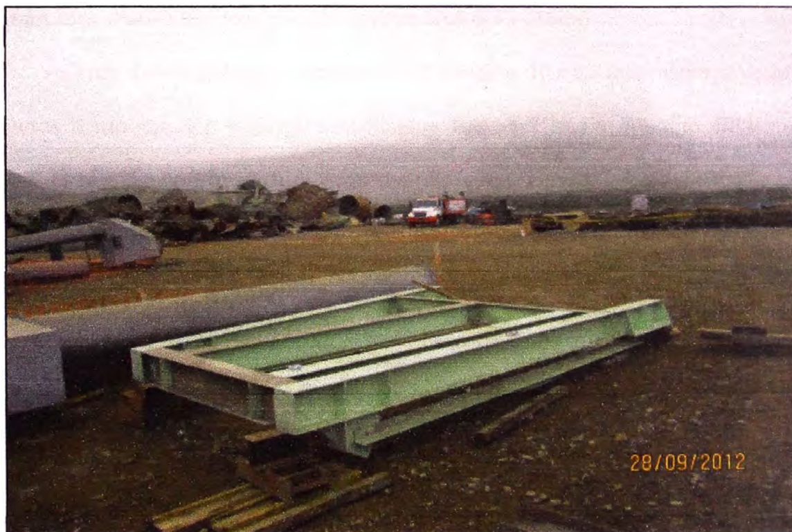
Figura 5.3: Preensamble de estructura B8
