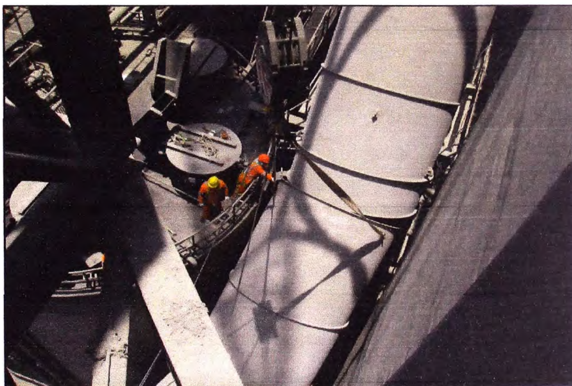
Figura 5.8: Montaje ducto A7 – Pieza N°1
