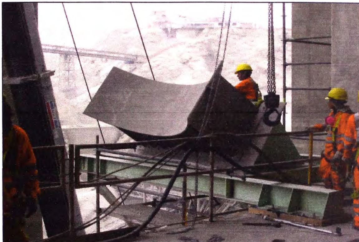
Figura 5.5 Montaje de soporte B8
