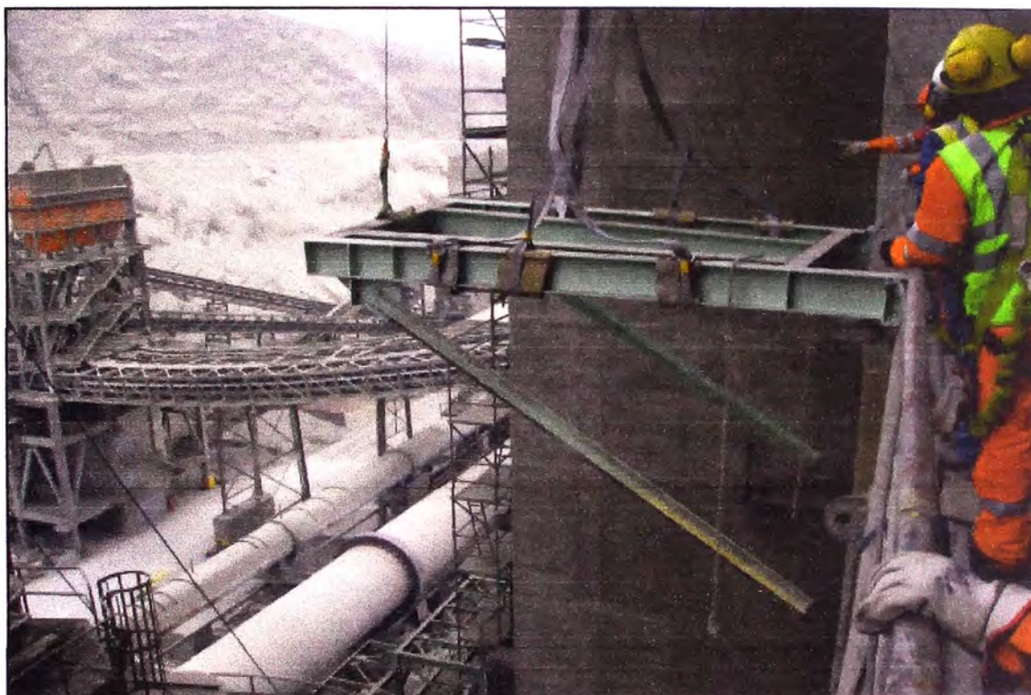
Figura 5.4: Montaje de estructura B8
