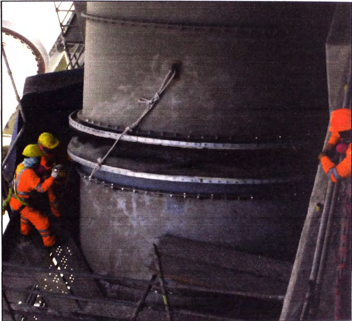
Figura 5.10: Torqueo de junta de expansión 421EJ4
