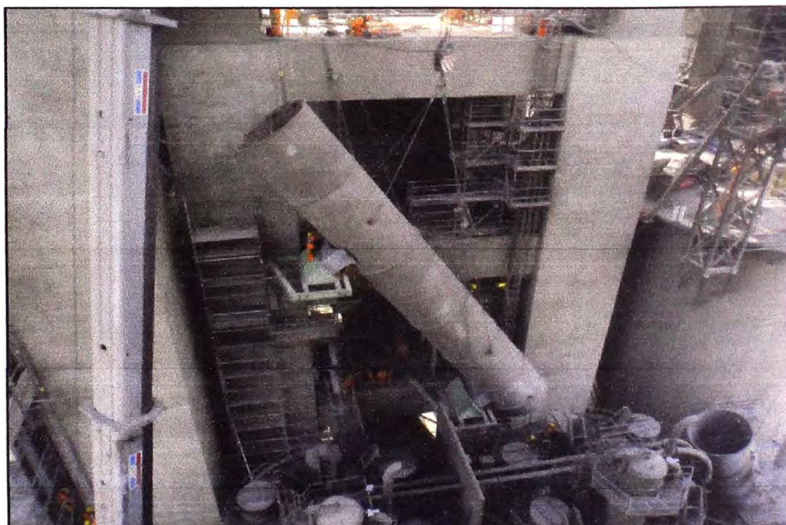
Figura 5.6: Montaje ducto A7 – Pieza N°2
