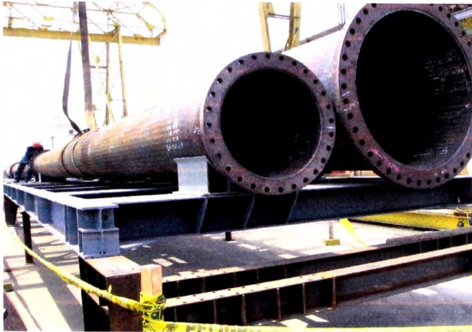
Figura 3.6 Alineamiento de los tubos
