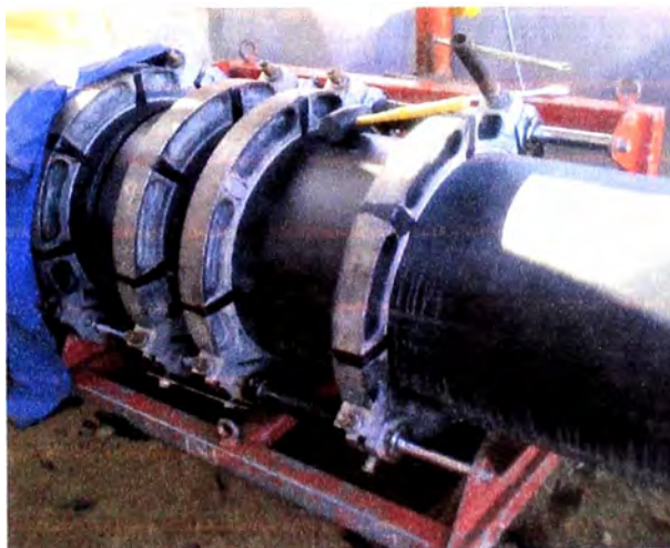
Figura 2.1 Imagen de termofusión a un tubo de 24” SDR11
