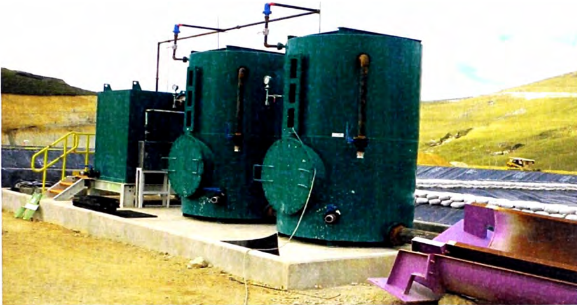
COLUMNAS DE CARBÓN Y MALLA DSM
